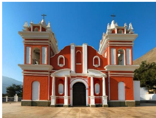
Figura 80: Iglesia Santiago Apóstol
