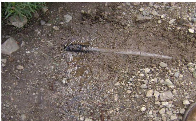
Figura 6: Línea de distribución existente
