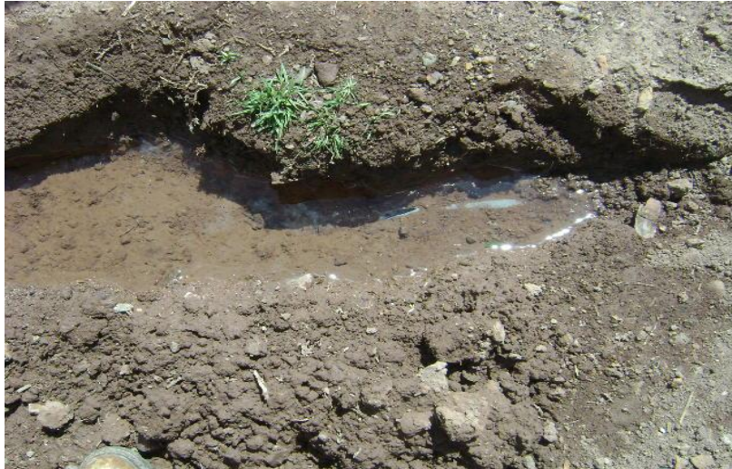
Figura 3: Línea de conducción existente
