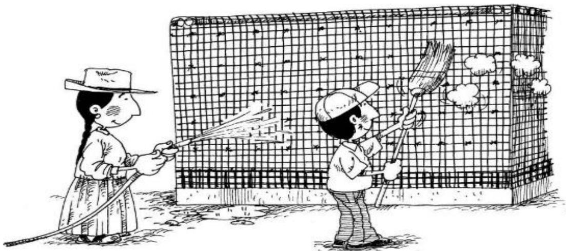
Nota. En la imagen se observa cómo se limpian las paredes para su respectivo remojo con agua para una mejor adherencia.
