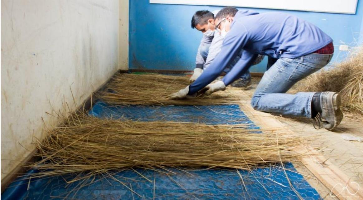
*Nota.* En la imagen se puede observar cómo es la instalación de pisos térmicos de manera natural, primero va un plástico, seguido de paja y terminando en madera.
