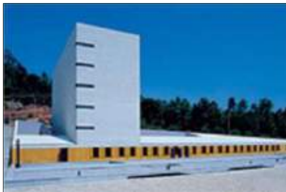
Figura 15. Fachada principal de la residencia de coimbra.
