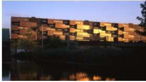
Figura 18. Vista de fachada.
