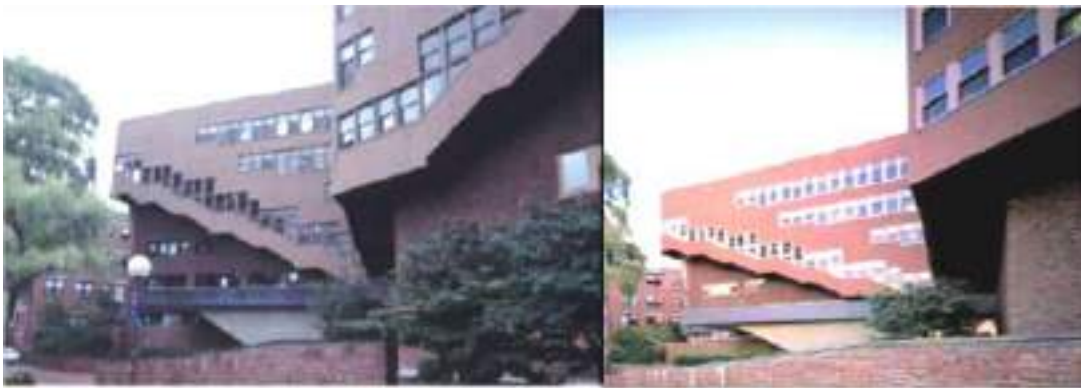
Figura 8. Vistas laterales e interna de casa Baker. Recuperado de galería de Google.
