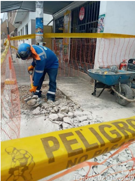
Uso EPP adecuado para la Actividad
