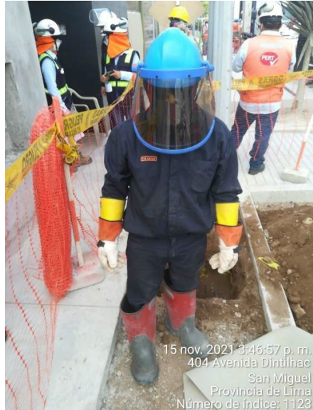
Uso EPP adecuado para la Actividad
