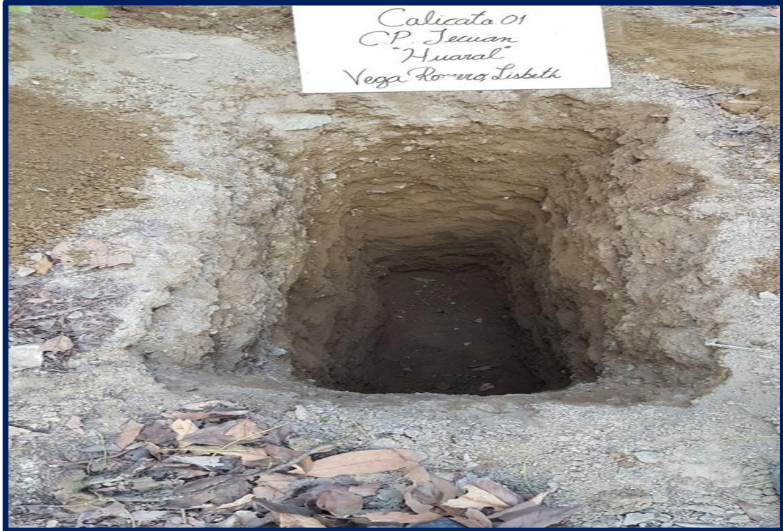
Fotografía. Extracción del material
