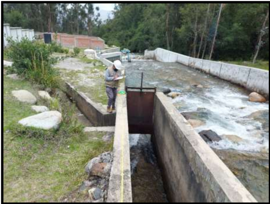
FOTOGRAFÍA N°06 MEDICIÓN DE LA LONGITUD DE CANAL DE CAPTACIÓN PARA EL LLENADO EN FICHA TÉCNICA
