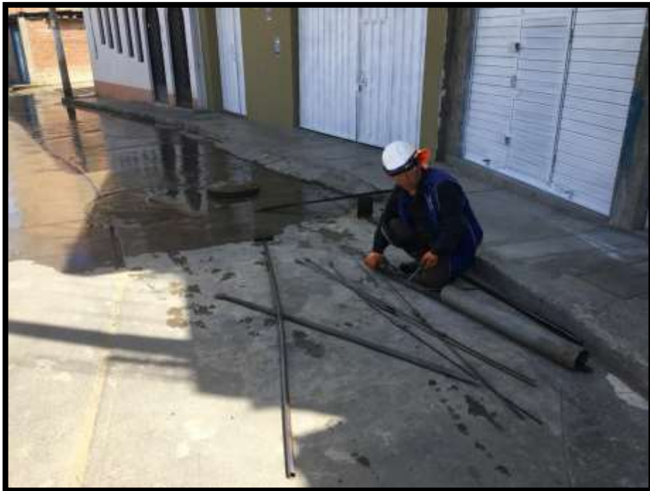
FOTOGRAFÍA N°22 REPARACIÓN DE BUZÓN COLAPSADO
