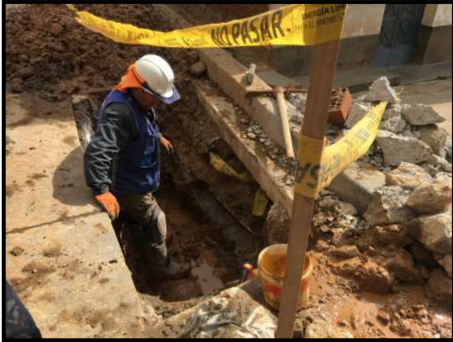
FOTOGRAFÍA N°21 REPARACIÓN DE LÍNEA DE CONDUCCIÓN TUBERÍA DE 10"
