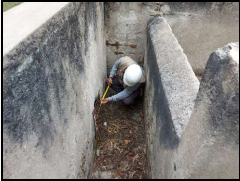
FOTOGRAFÍA N°13 MEDICIÓN DE TUBERÍA DE SALIDA A LÍNEA DE ADUCCIÓN QUE TIENE UN DIÁMETRO DE 12"
