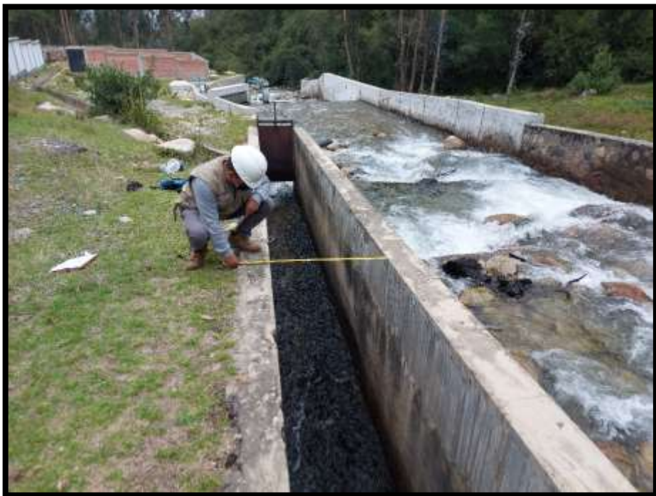
FOTOGRAFÍA N°04 MEDICIÓN DEL ANCHO DE CANAL PARA EL LLENADO EN LA FICHA TÉCNICA
