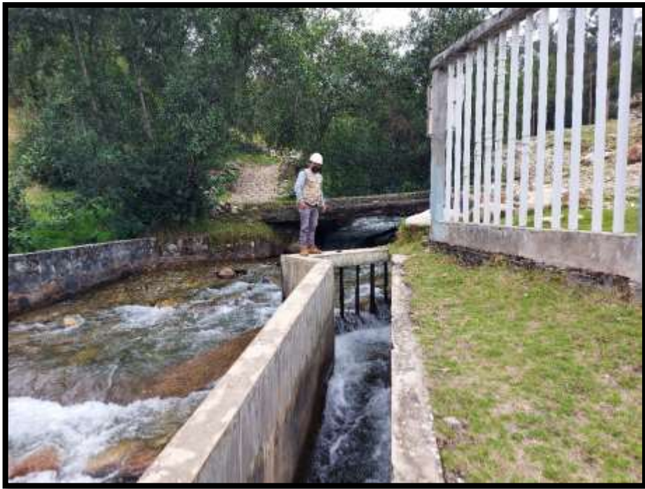
FOTOGRAFÍA N°01 CAPTACIÓN DE YARUSH
