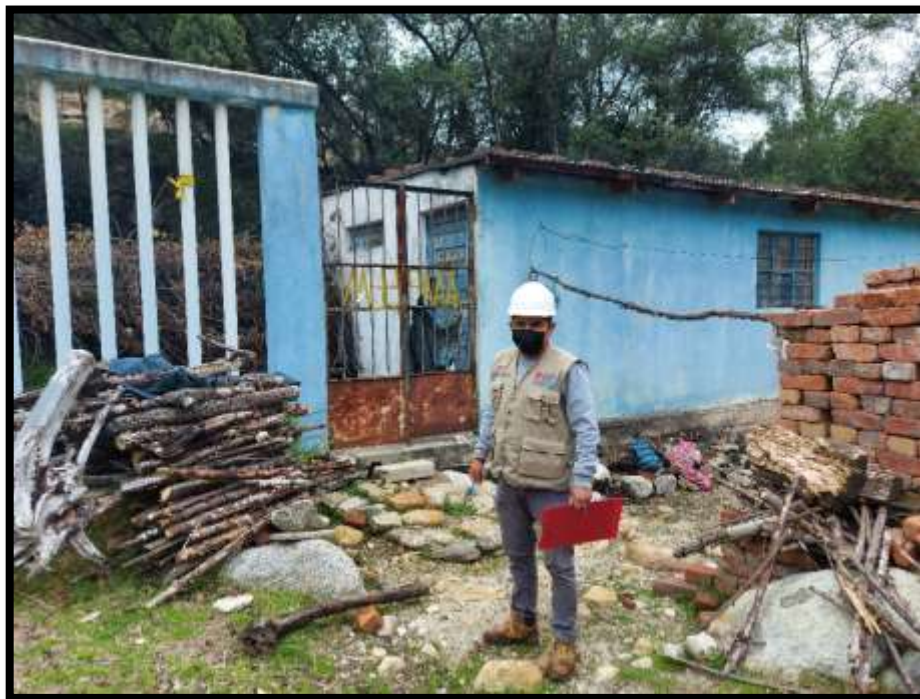
FOTOGRAFÍA N°10 INGRESO PRINCIPAL HACIA EL DESARENADOR
