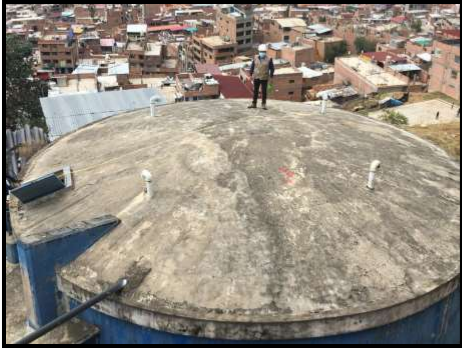
FOTOGRAFÍA N°19 MEDICIÓN DEL DIÁMETRO DEL RESERVORIO
