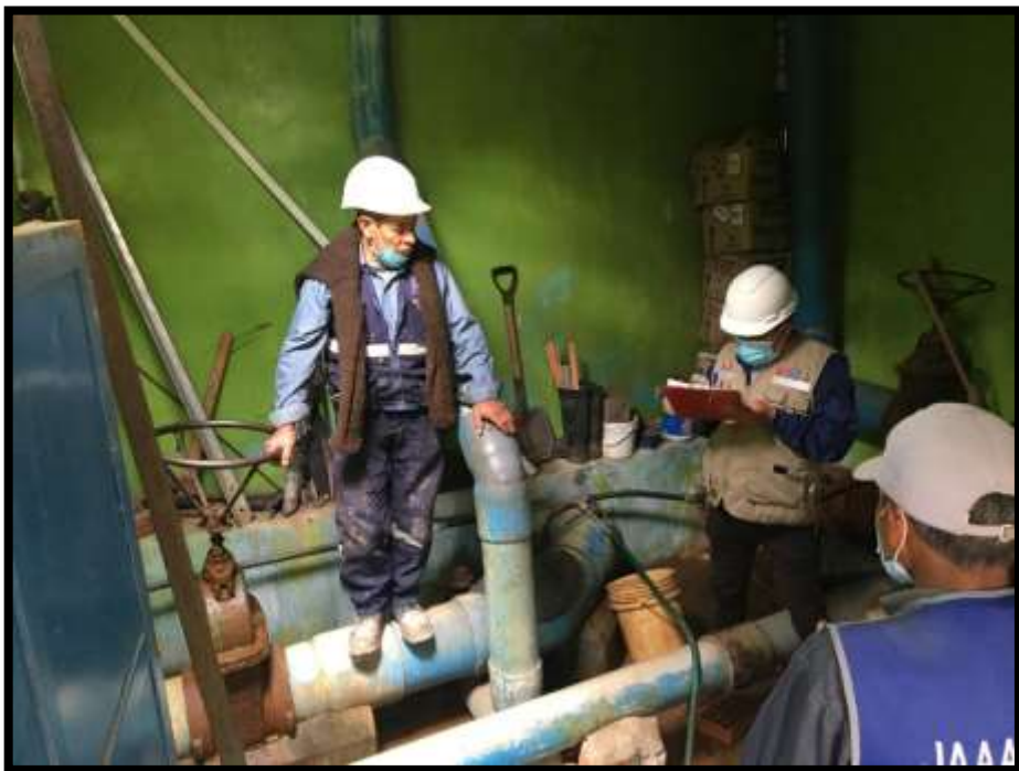
FOTOGRAFÍA N°16 EVALUACIÓN DE LA CASETA DE VÁLVULAS CON EL PERSONAL A CARGO
