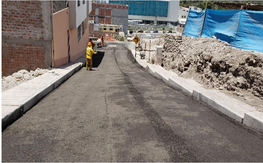
Figura 23. Pendiente mayor se utilizó el rodillo de 2tn
