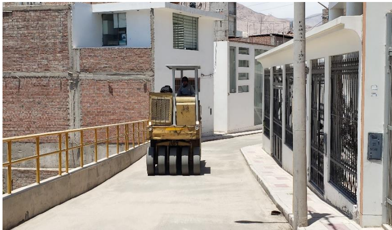
Figura 21. Compactación de carpeta asfáltica con rodillo neumático
