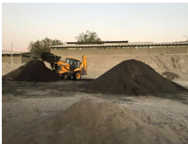
Figura 13. Producción de mezcla asfáltica
