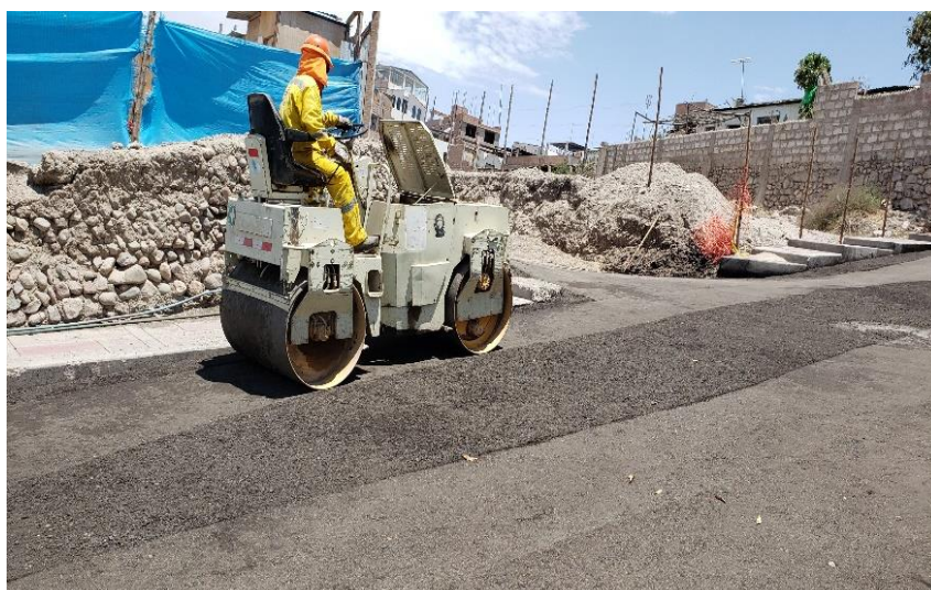
Figura 22. Conformación de mezcla asfáltica con rodillo de 2 tn
