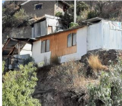
15 SISTEMA CONSTRUCTIVO PREFABRICADO
