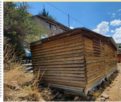
34 SISTEMA CONSTRUCTIVO PREFABRICADO
