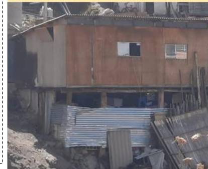
28 SISTEMA CONSTRUCTIVO PREFABRICADO
