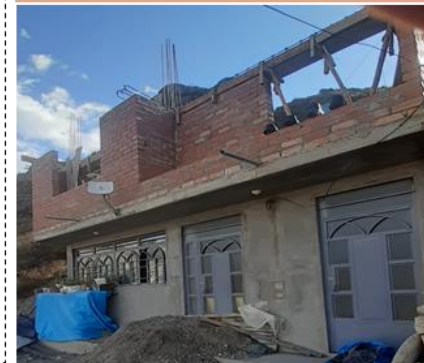
42 SISTEMA CONSTRUCTIVO ALBAÑILERIA
