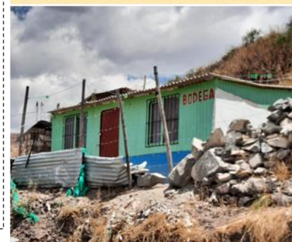
29 SISTEMA CONSTRUCTIVO PREFABRICADO
