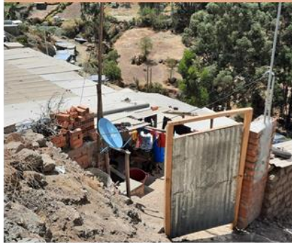
37 SISTEMA CONSTRUCTIVO ALBAÑILERIA
