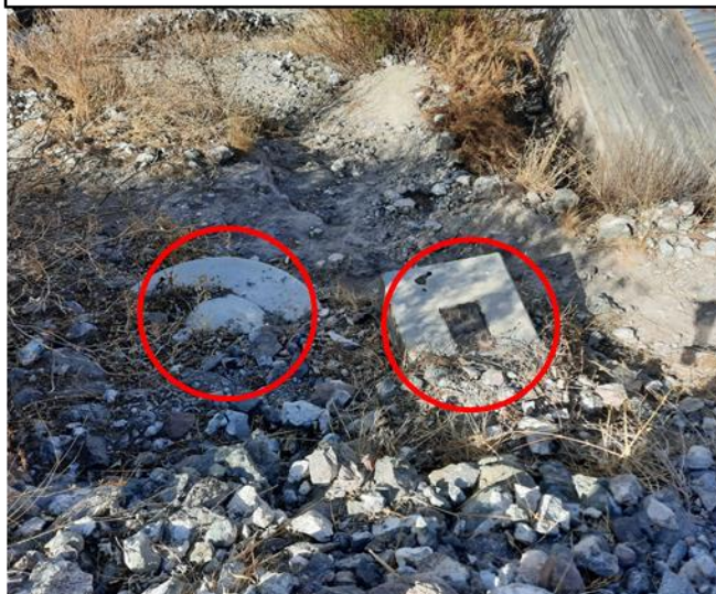
BUZÓN DE DESAGUE Y CAJA DE AGUA
