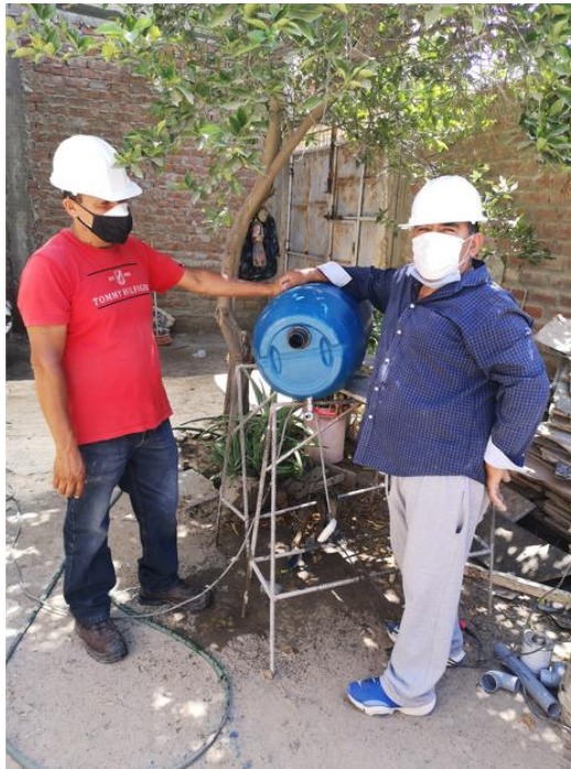
Fotografía 4. Culminación y demostración de agujero con la tubería colocada de 2" de diámetro. Parte inferior.
