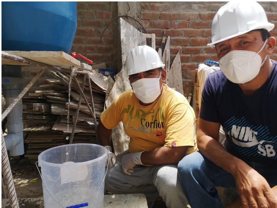
Fotografía 10. Envase y medida donde se recolectará el agua ya filtrada.
