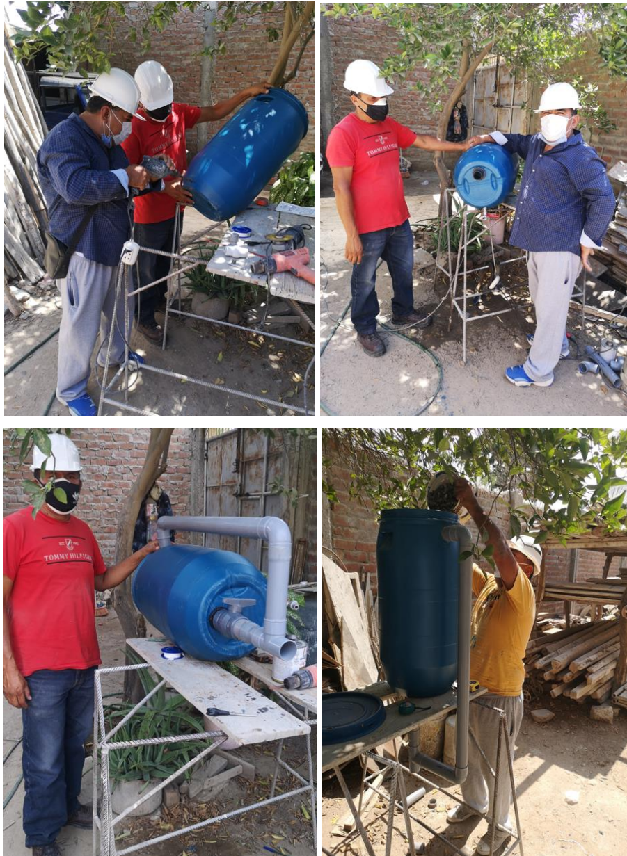
Figura 5: Procedimiento de construcción del sistema de filtración. A la izquierda superior se observa la perforación del tanque para acoplar las tuberías y accesorios. A la derecha superior se observa la perforación inferior del tanque que tiene como finalidad ser la tubería de limpia, y desaguar las aguas de manera más rápida para efectos de mantenimiento. A la izquierda inferior, se observa la estructura del filtro terminada con la instalación de los accesorios, las válvulas y tuberías de PVC. A la derecha inferior se observa el llenado del filtro con el material granular de acuerdo a lo estipulado en los planos.
