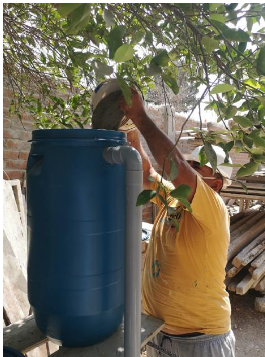
Fotografía 8. Llenado de la arena gruesa en el cilindro para realizar el filtrado de las aguas grises. E: 0.10 cm.
