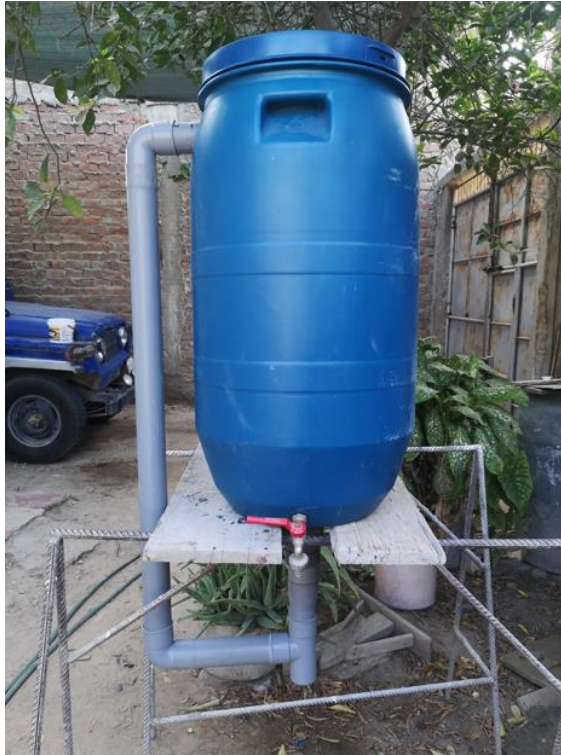
Figura 6: Sistema de filtración concluido
