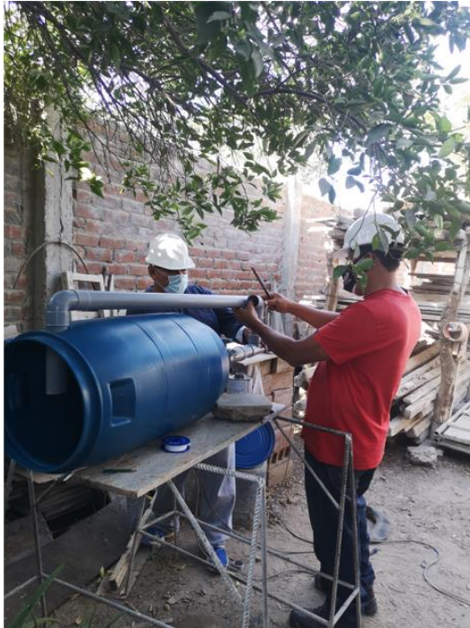
Fotografía 5. Instalación y armado de los diferentes accesorios para la realización del filtrado.
