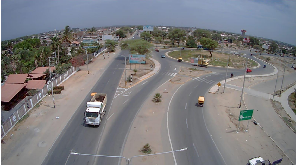
VISTA AEREA DE ENTRADA Y SALIDA DEL RAMAL PIURA -SULLANA
