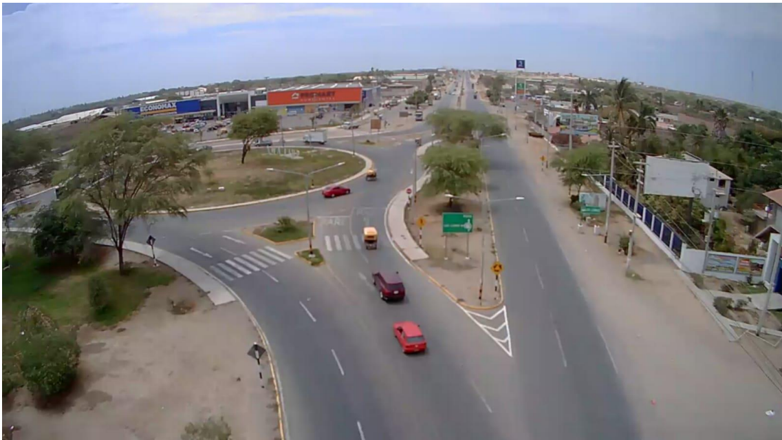
VISTA AEREA DE ENTRADA Y SALIDA EN EL RAMAL SULLANA -PIURA
