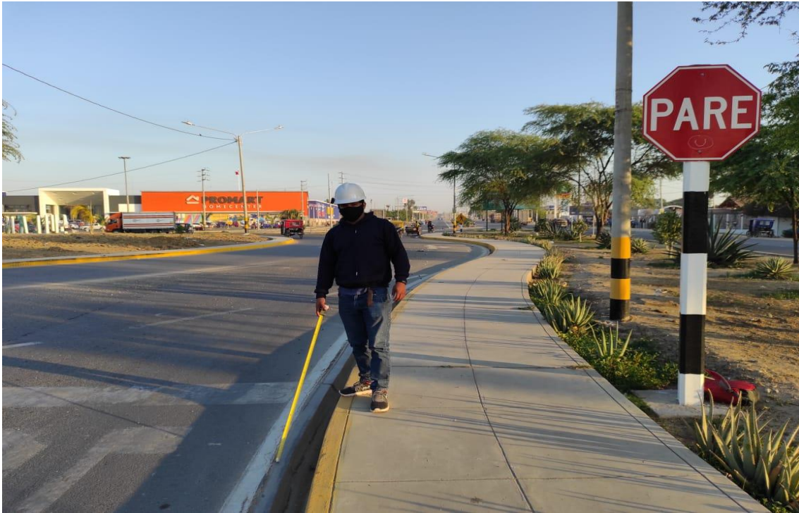
VEREDA, CUNETA Y SEÑAL DE PARE EN LA ROTONDA
