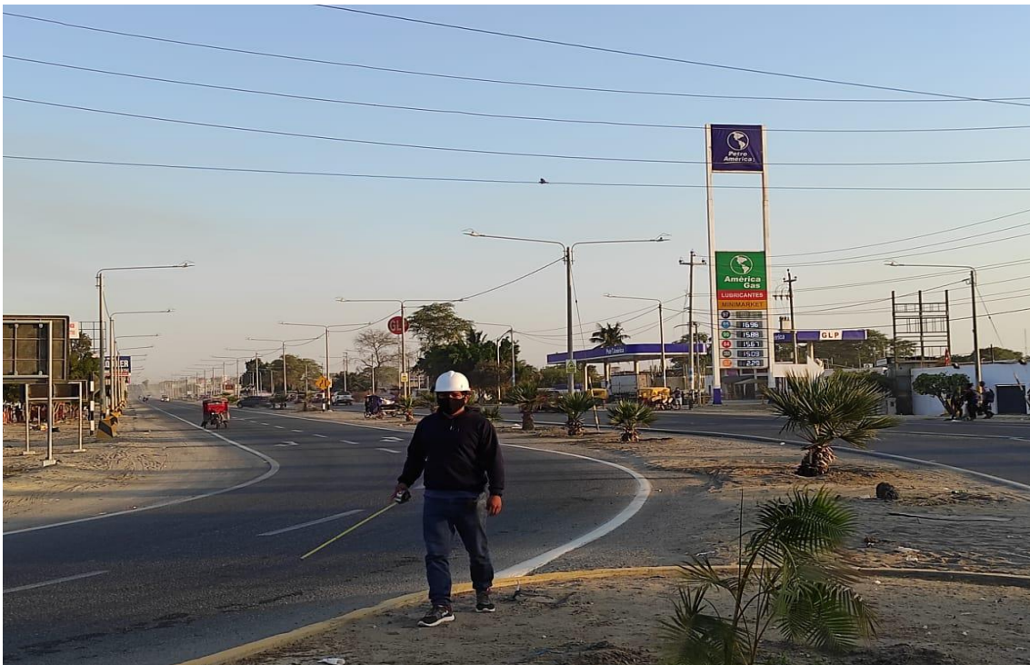
RAMAL DE ENTRADA PIURA SULLANA
