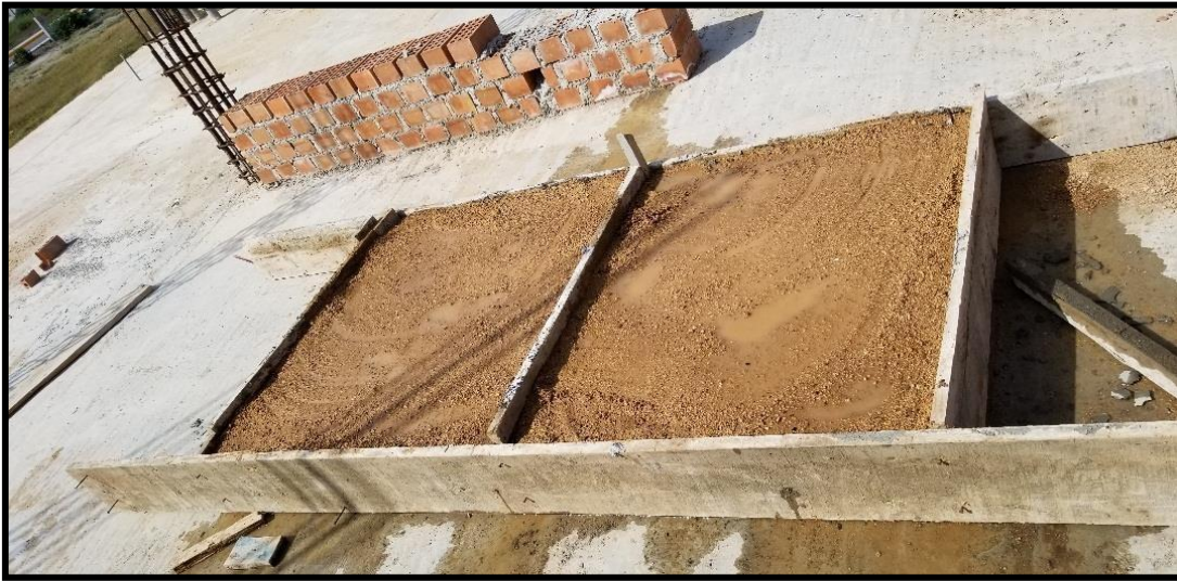
Figura 32: Secado y curado de losas
