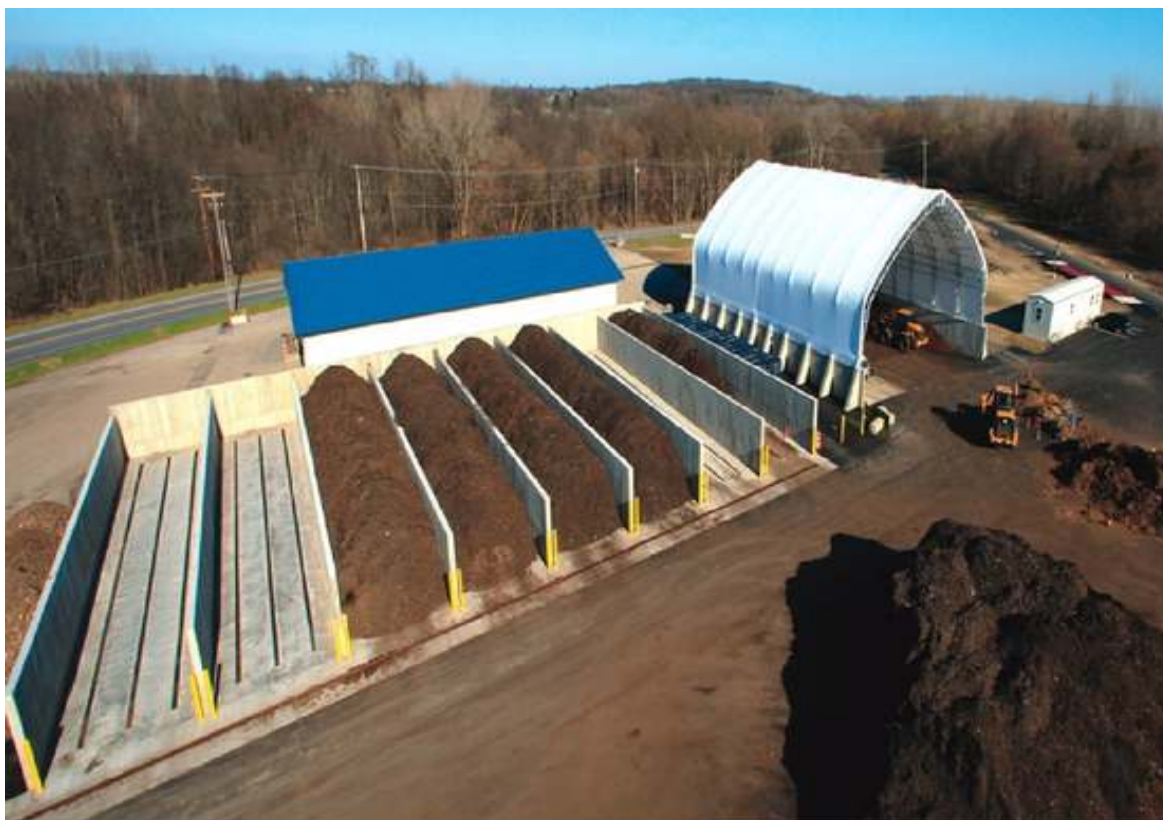
Figura N° 1. Planta de valorización de residuos sólidos orgánicos.
