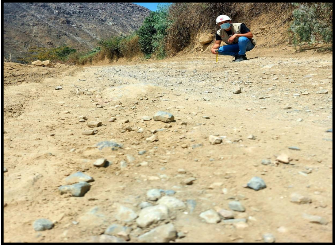
Tramo KM 08+713 hasta el tramo KM 09+213, Tipo de falla por erosión
