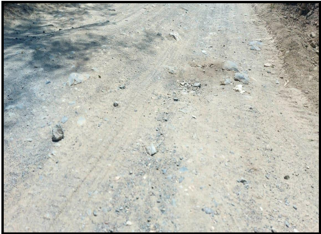
Tramo KM 08+713 hasta el tramo KM 09+213, Tipo de falla por erosión
