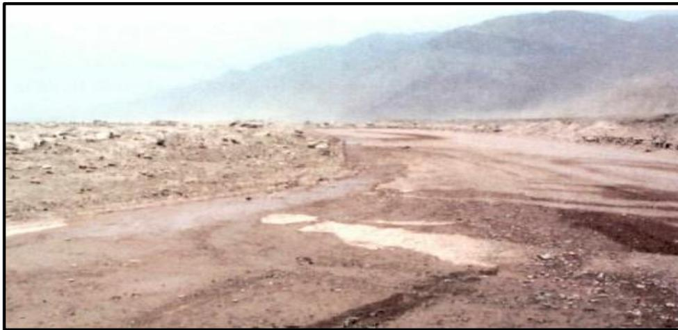
**Figura 18.** Baches (huecos)/Gravedad 2: Necesita una capa de material adicional.
