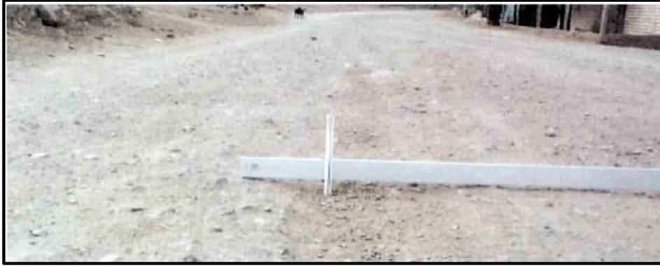
**Figura 12.** Deformación, Gravedad 2: Huellas/hundimientos entre 5 cm y 10 cm.
