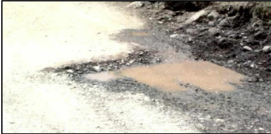
**Figura 17.** Baches (huecos)/Gravedad 1: Pueden repararse por mantenimiento rutinario.
