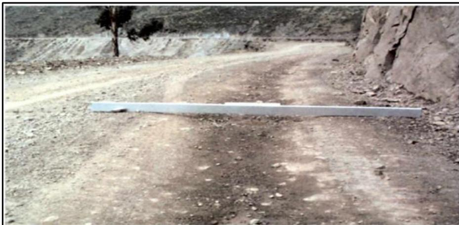
**Figura 11.** Deformación, Gravedad 1: Huellas/hundimientos sensibles al usuario < 5 cm.
