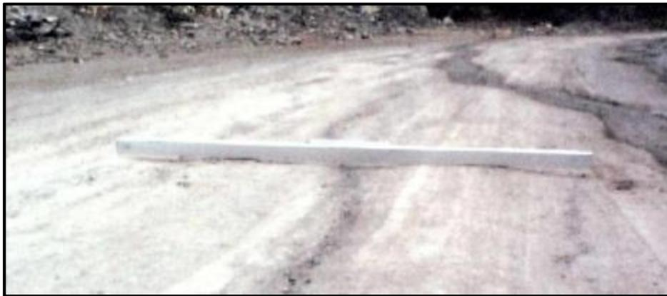
**Figura 14.** Erosión, Gravedad 1: Sensible al usuario, pero < 5cm.
