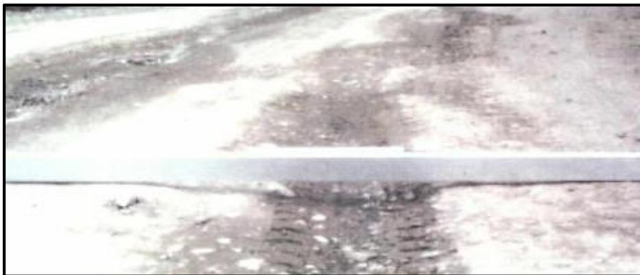
**Figura 15.** Erosión, Gravedad 2: Profundidad entre 5 cm y 10 cm.
