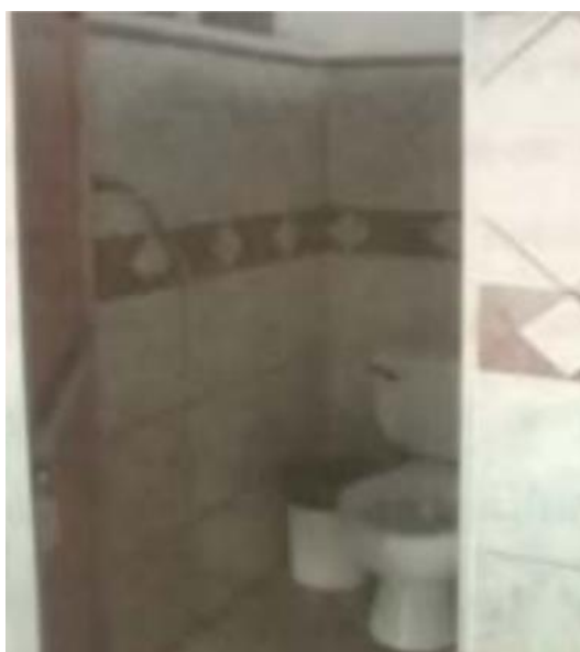
Ilustración 2. Servicios sanitarios de establecimientos que brindan servicio al adulto mayor
