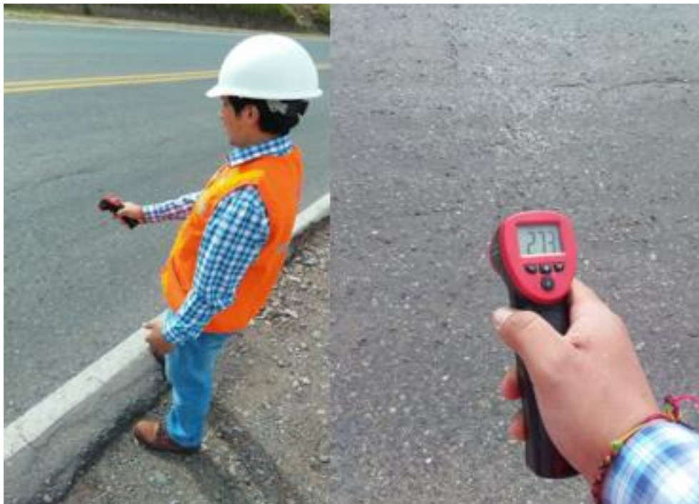
Figura 3.3 Tomando Temperatura con Laser a la Superficie de la Capa Asfáltica
