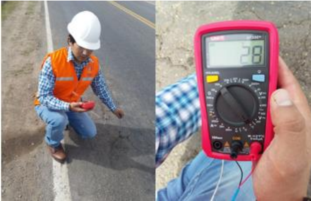
Foto N°03 Tomando Temperatura con el Termómetro con Vástago a Profundidad de 2" de la Carpeta Asfáltica
