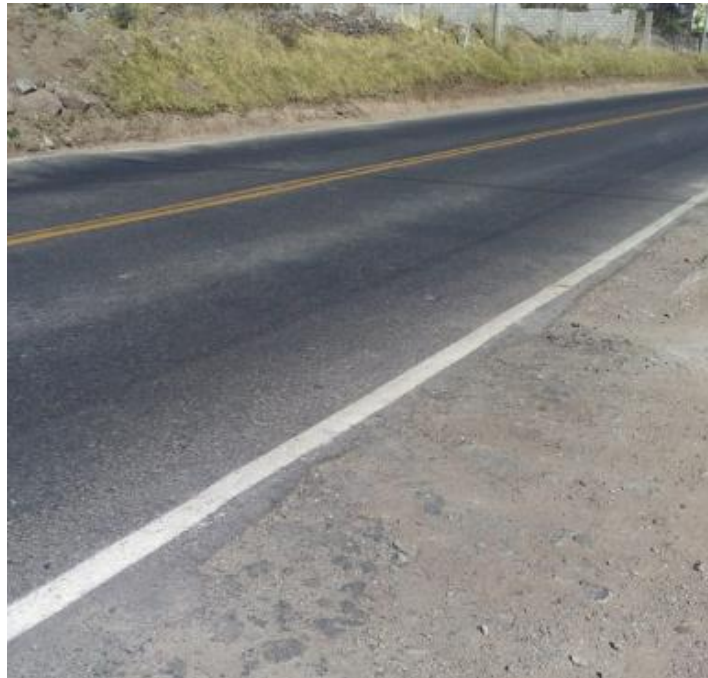
Figura 2.4 Carpeta Asfáltica del Tramo en Estudio
