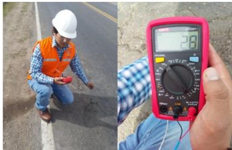
Figura 3.4 Tomando Temperatura con el Termómetro con Vástago a Profundidad de 2" de la Carpeta Asfáltica
