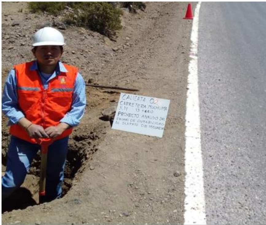
Foto N°01 Muestra de la Calicata
