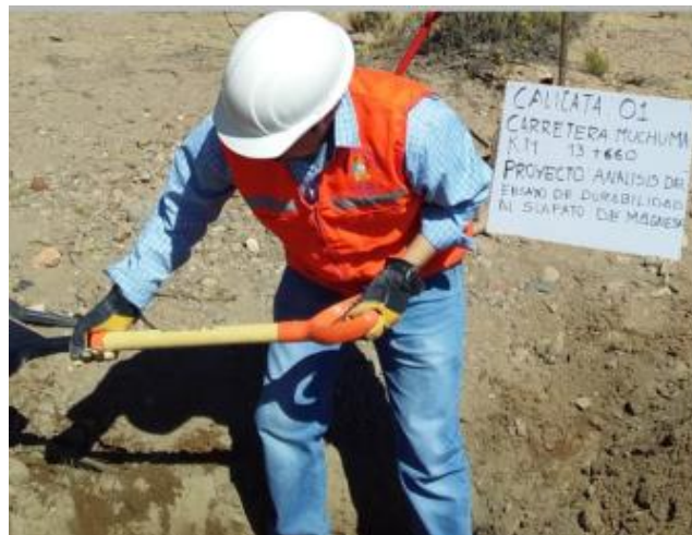
Figura 3.1 Excavación de la Calicata
