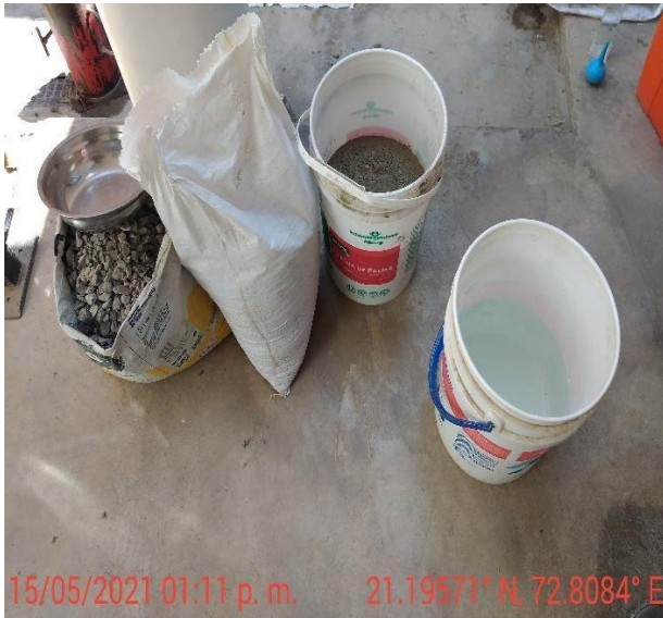
Fotografía 7. Materiales antes de realizar la mezcla
