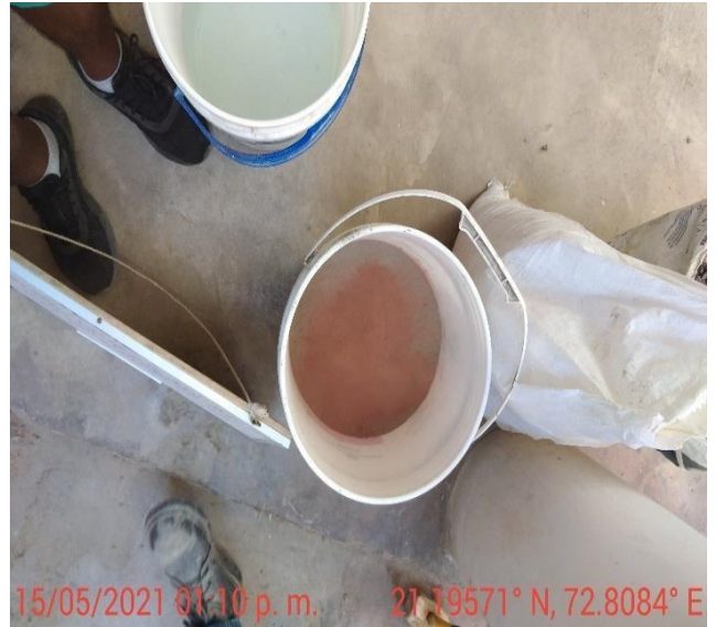
Fotografía 8. Mezcla de polvo de ladrillo con el cemento
