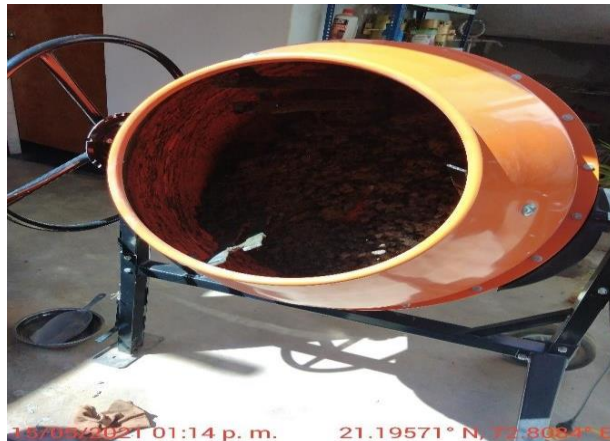
Fotografía 9. Realizando la mezcla de concreto
