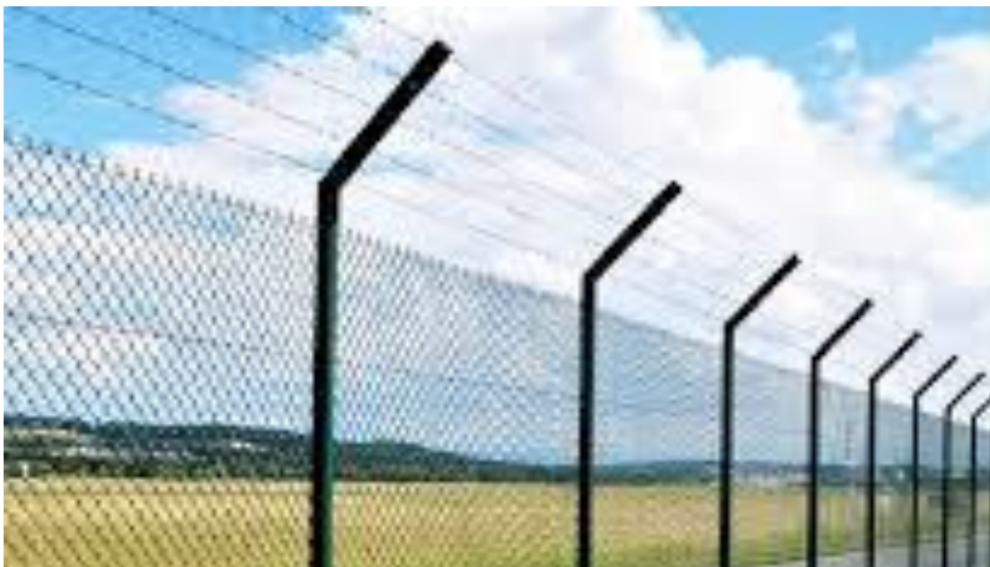
Figura N°02: Cerco de malla galvanizada tipo cocada.
