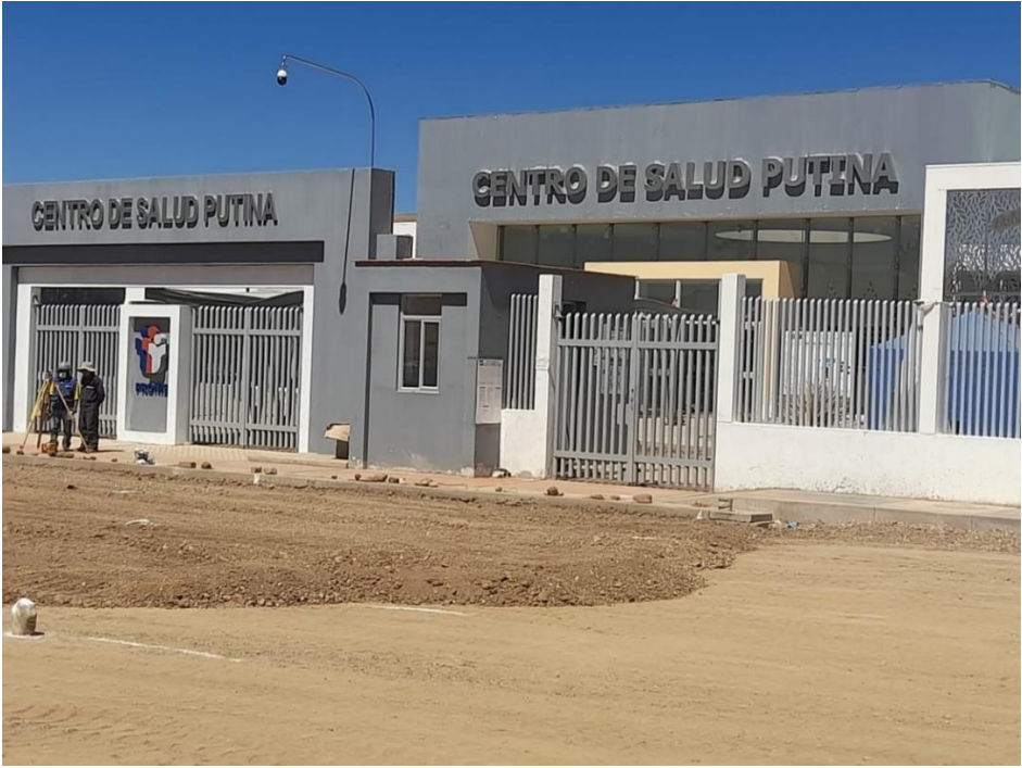
Centro de Salud donde se realizó la ejecución del proyecto de investigación
