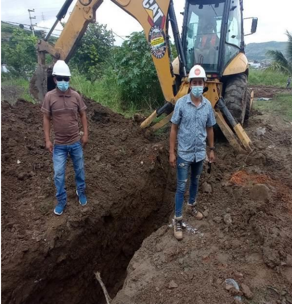
Foto N° 1: realizado de calicata con ayuda de retroexcavadora.
