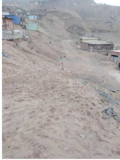
LEVANTAMIENTO TOPOGRÁFICO, TOMAS CON EL GPS EN LA CALLE 2 Y MEDICIÓN DE SECCIONES DE VIA
