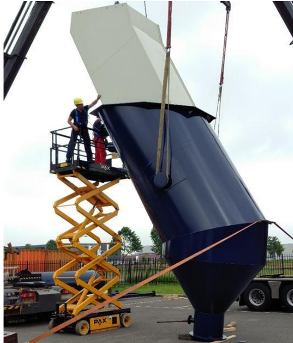
Figura 01 : Sedimentador lamelar (imagen referencial)
