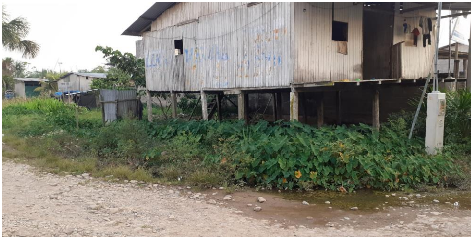
Figura 20. Suelo con un alto grado de humedad
