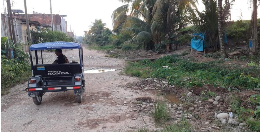
Figura 15. Falta de Pavimentación y Cuneta
