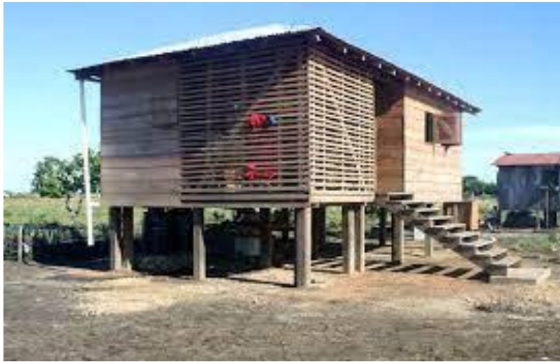
Figura 5. Componentes de una vivienda de madera
