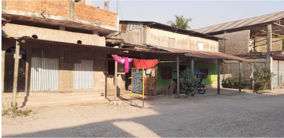
Figura 18. Vivienda de Madera y Albañilería
