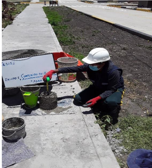
Figura 32. Control de asentamiento del concreto. Fuente: Producción propia (2021).
