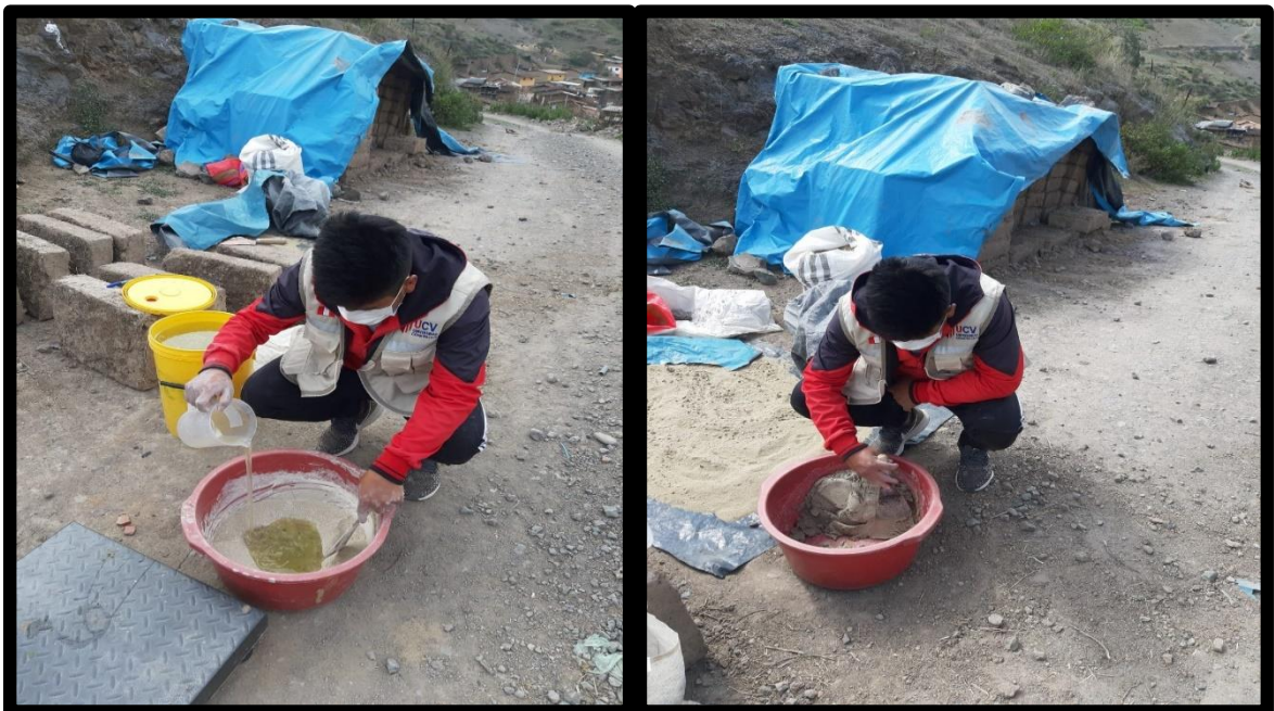
Figura 24. Adición y preparación de mortero con baba de nopal
