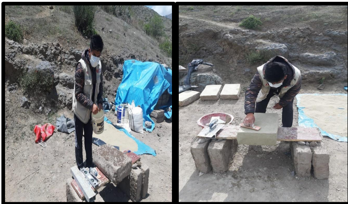
Figura 25. Humedecer y tarrajeo del adobe con el mortero
