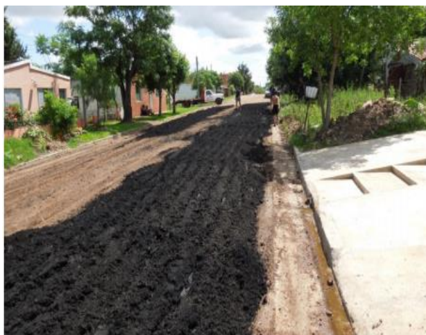
Figura 3. Estabilización del Suelo
