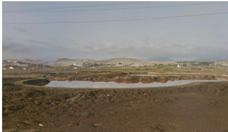
FIGURA N° 4: Estado de abandono del circuito turístico dentro de los humedales – Av. Panamericana Norte
