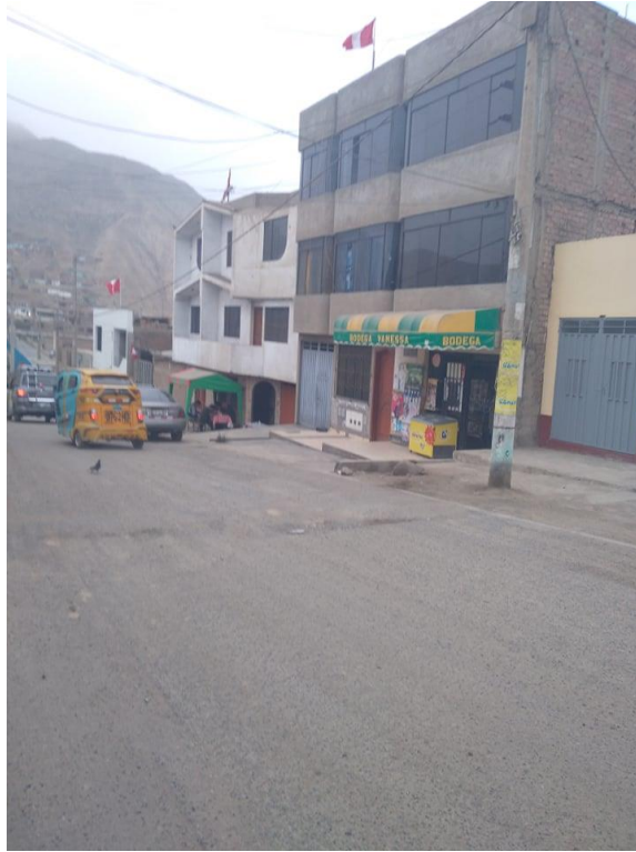
Imagen N° 5: Vivienda unifamiliar de 3 pisos con el sistema A.C.
