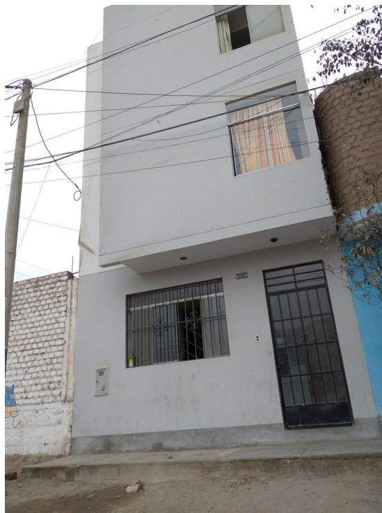
Imagen N° 8: Vivienda unifamiliar de 3 pisos con el sistema A.C.
