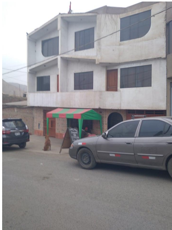
Imagen N° 6: Vivienda unifamiliar de 3 pisos con el sistema A.C.
