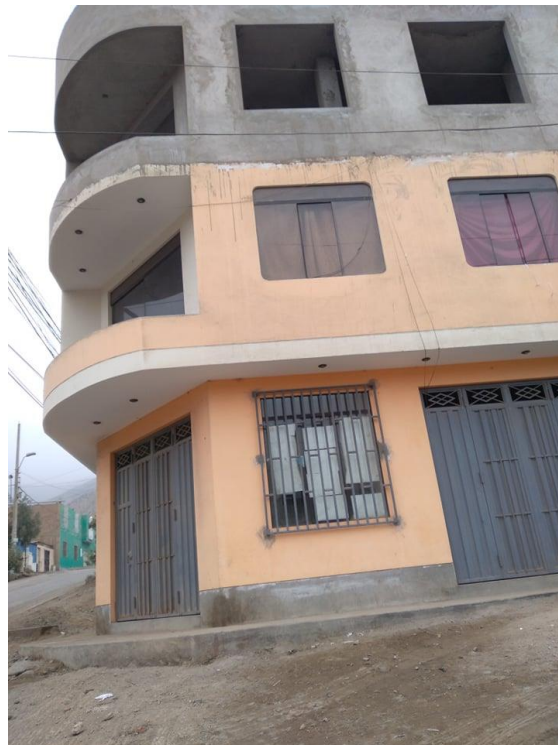
Imagen N° 12: Vivienda unifamiliar de 3 pisos con el sistema A.C.
