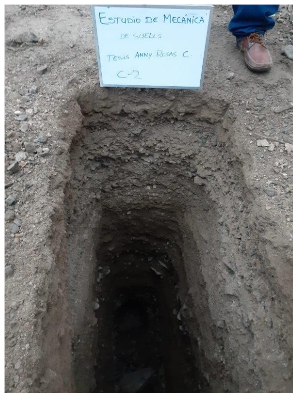
Imagen N° 2: Calicata – 2 con 3m. de profundidad.
