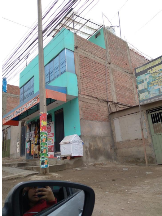
Imagen N° 11: Vivienda unifamiliar de 3 pisos con el sistema A.C.
