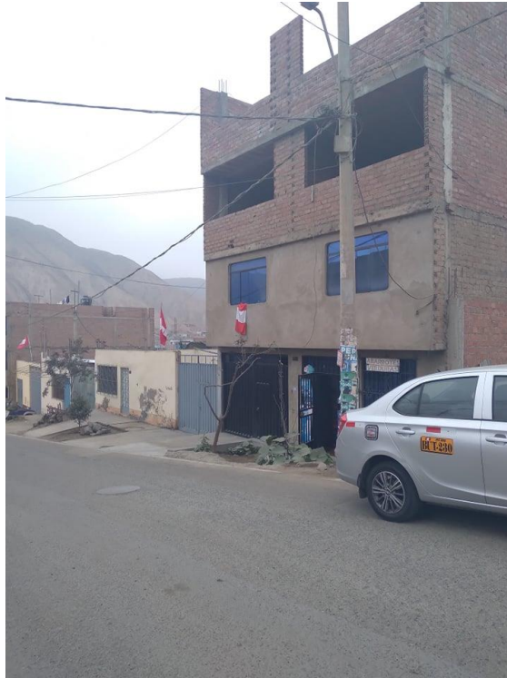
Imagen N° 7: Vivienda unifamiliar de 3 pisos con el sistema A.C.
