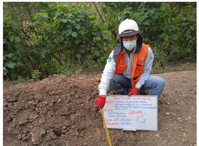
Figura 26: calicata en zona crítica
