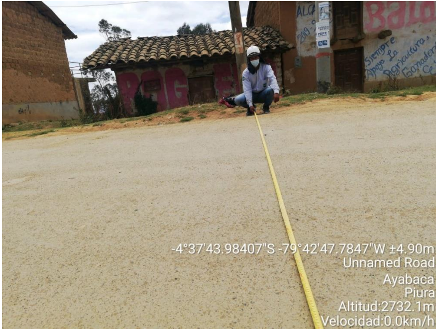
Figura 22: medición ancha de vía
