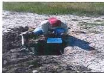
Ubicación de la calicata 03
