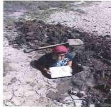
ubicación de la calicata 16
