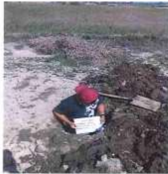
Ubicación de la calicata 15
