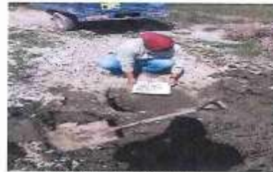
Ubicación de la calicata 04
