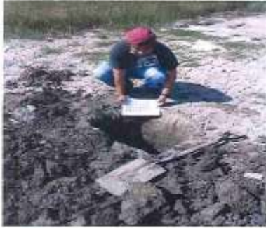
Ubicación de la calicata 11
