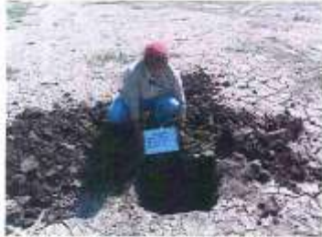
Ubicación de la calicata 01
