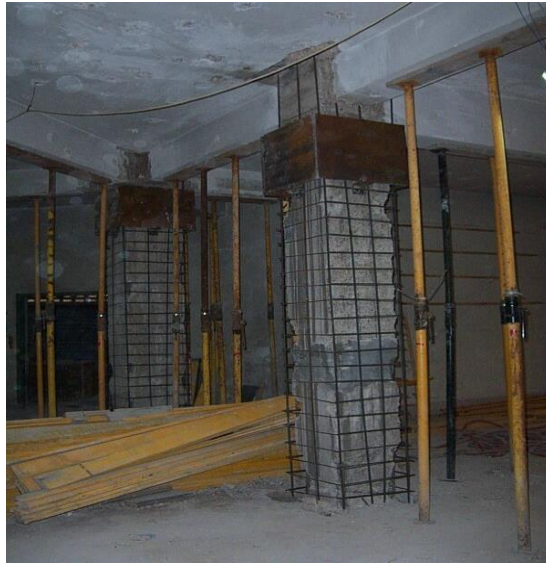
Figura 4: técnica de encamisado en columnas
