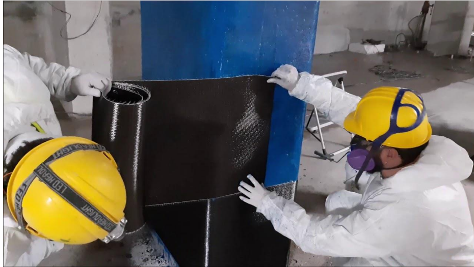
Figura 6: aplicación de fibra de carbono en columna
