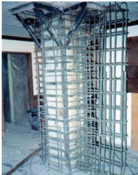
Figura 5: técnica de ensanchamiento de columnas
