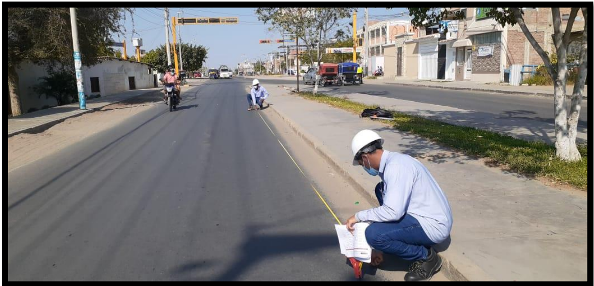
FOTO 04 Medición y clasificación de la falla encontrada en la superficie del pavimento
