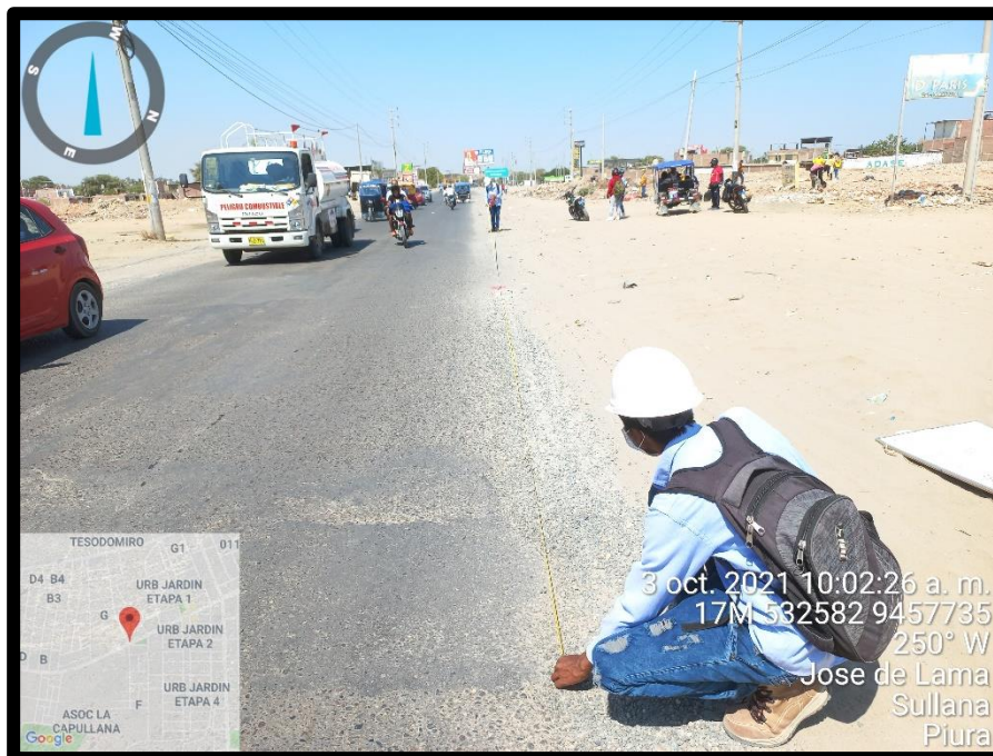
FOTO 17 Medición y clasificación de la falla encontrada en la superficie del pavimento
