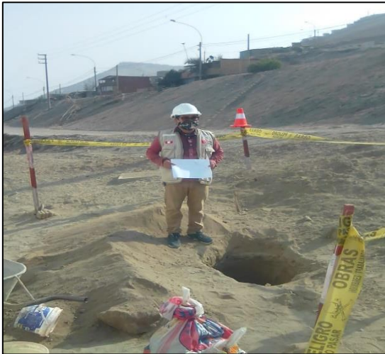
Figura 9. Realización de la calicata
