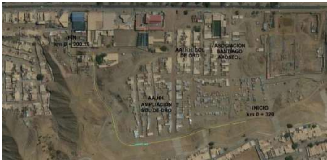
Figura 5: Localización de canal Evacuador de aguas pluviales.
