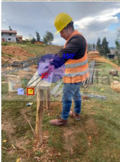
Figura N°84: Medición Grupo B: Envarillado de zapata.
