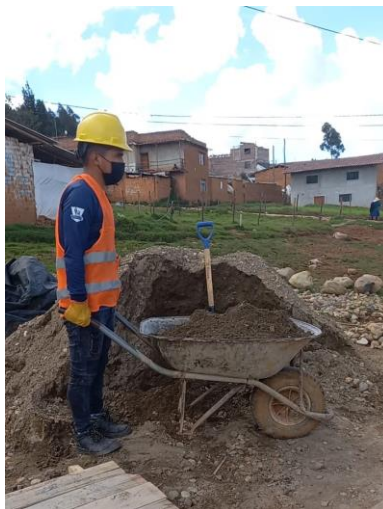
Figura N°122: Levantamiento de origen Post evaluación: Vaciado de zapata 1
