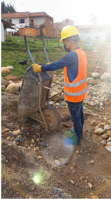
Figura N°123: Levantamiento de destino Post evaluación: Vaciado de zapata 1
