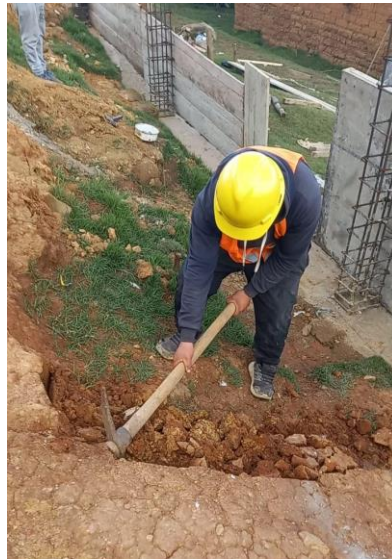
Figura N°59: Levantamiento de origen: Excavación 2.
