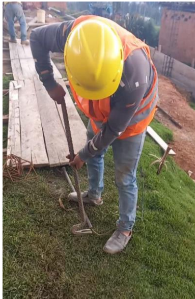
Figura N°62: Levantamiento de destino: Envarillado de zapata.
