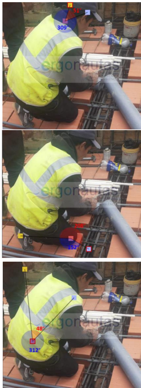
Figura Nº36: Medición Grupo A: Instalación sanitaria 2.
