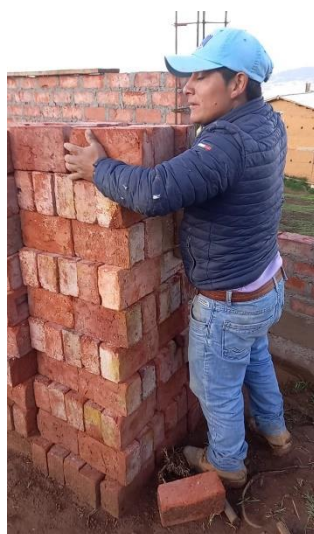
Figura N°67: Levantamiento de origen: Colocación de bloques.
