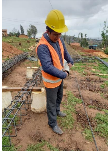
Figura N°113: Post evaluación de las extremidades superiores: Instalación sanitaria 2.
