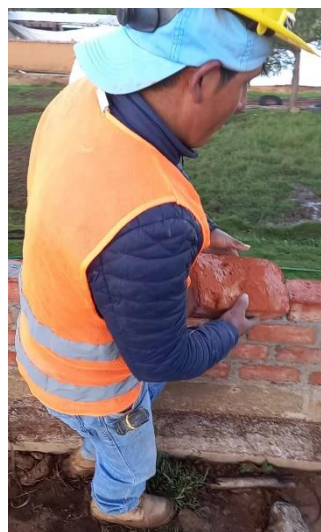
Figura N°126: Levantamiento de origen Post evaluación: Colocación de bloques
