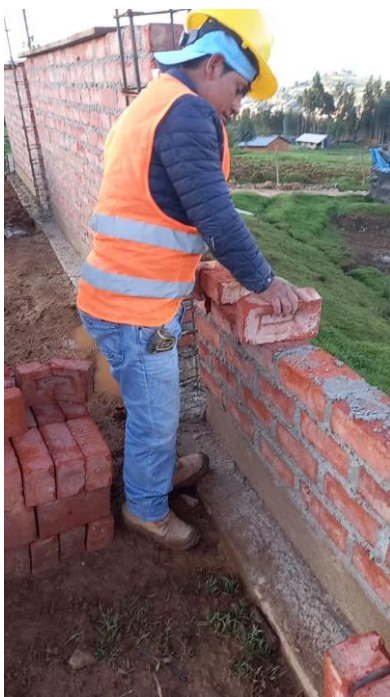
Figura N°127: Levantamiento de destino Post evaluación: Colocación de bloques
