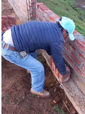
Figura N°68: Levantamiento de destino: Colocación de bloques.
