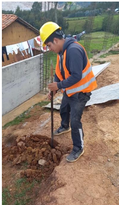
Figura N°118: Levantamiento de origen Post evaluación: Excavación 2
