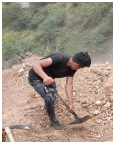
Figura N°46: Pre evaluación de las extremidades superiores: Excavación 2.
