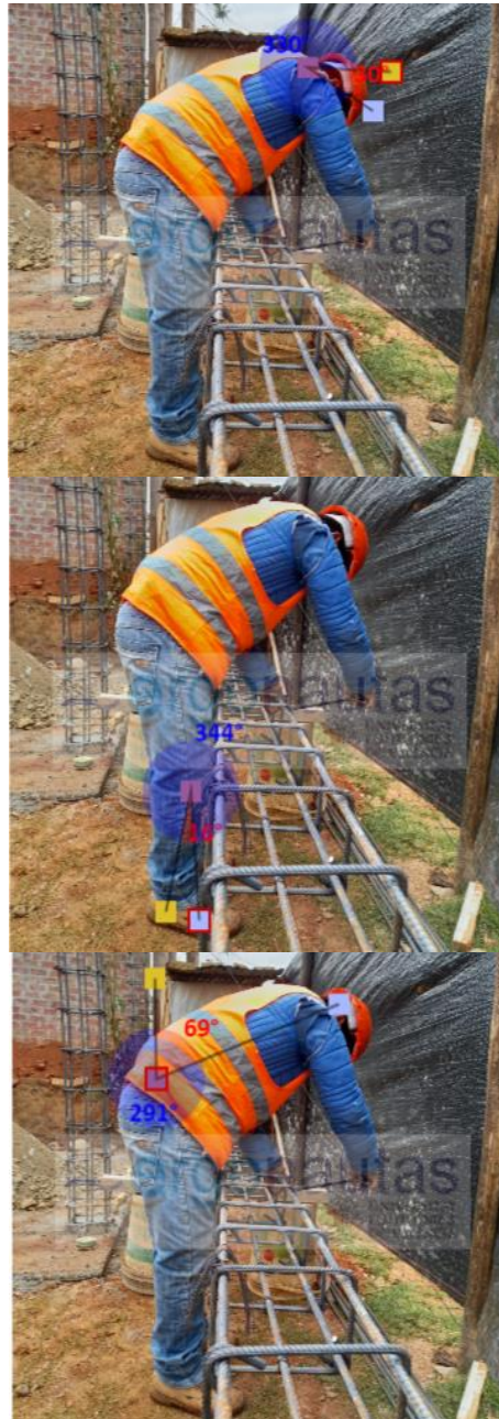
Figura N°21 : Medición Grupo A: Envarillado de zapata.
