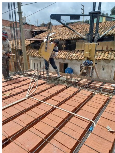
Figura N°133: Levantamiento de destino Post evaluación: Columnas-vigas-dinteles
