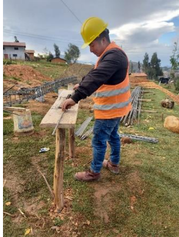
Figura N°108: Post evaluación de las extremidades superiores: Envarillado de zapata.
