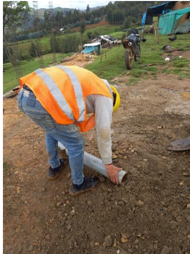
Figura N°128: Levantamiento de origen Post evaluación: Instalación Sanitaria 1
