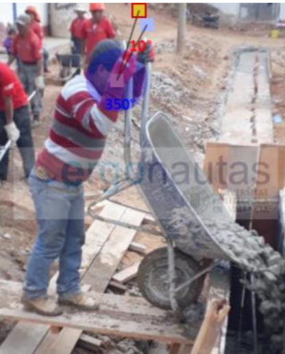
Figura N°90: Medición Grupo B: Vaciado de zapata 2.
