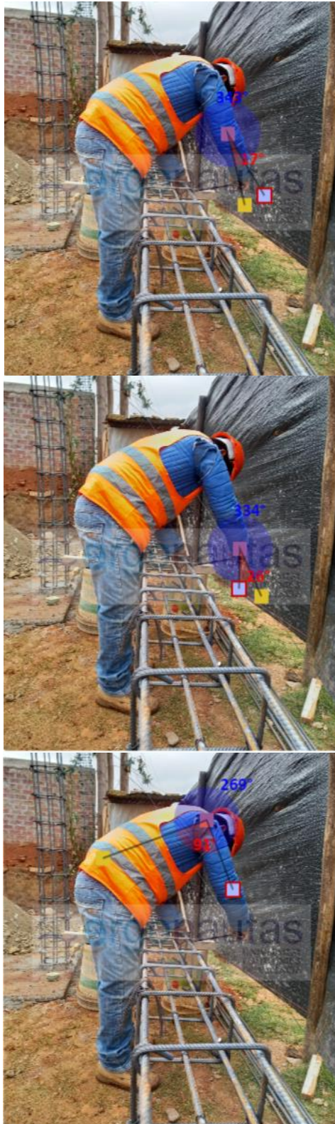
Figura Nº22: Medición Grupo B: Envarillado de zapata.
