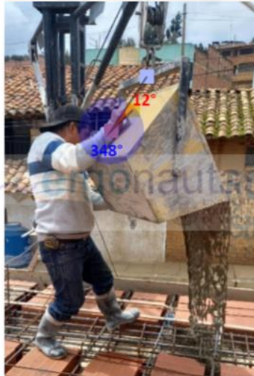
Figura N°101: Medición Grupo B: Columnas-vigas-dinteles.
