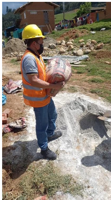
Figura N°125: Levantamiento de destino Post evaluación: Vaciado de zapata 2
