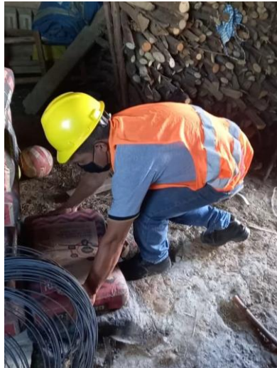
Figura N°65: Levantamiento de origen: Vaciado de zapata 2.
