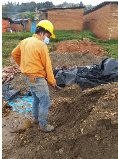
Figura N°117: Levantamiento de destino Post evaluación: Excavación 1
