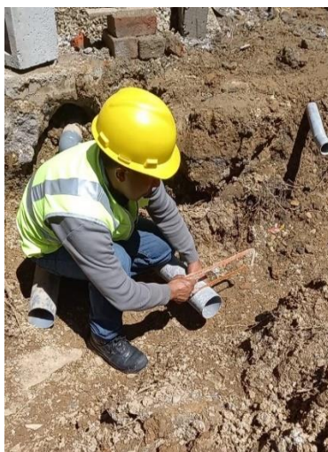
Figura N°72: Levantamiento de destino: Instalación sanitaria 2.
