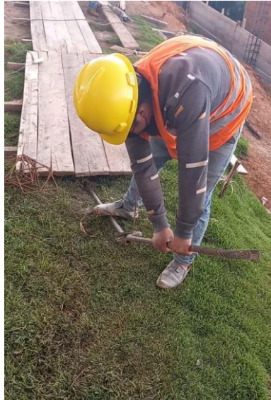
Figura N°61: Levantamiento de origen: Envarillado de zapata.
