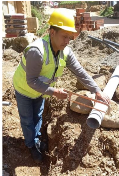
Figura N°130: Levantamiento de origen Post evaluación: Instalación Sanitaria 2
