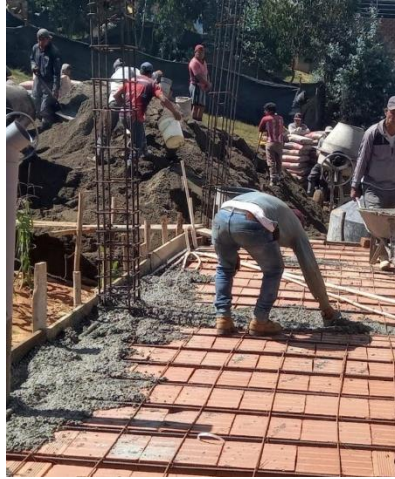
Figura N°76: Levantamiento de destino: Acabados
