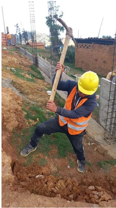
Figura N°60: Levantamiento de destino: Excavación 2.
