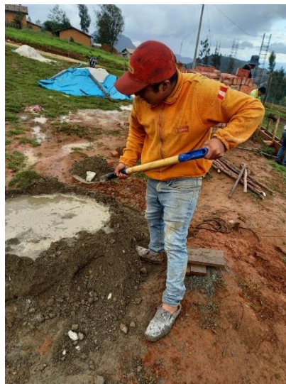
Figura N°58: Levantamiento de destino: Excavación 1.
