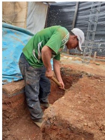
Figura N°45: Pre evaluación de las extremidades superiores: Excavación 1.
