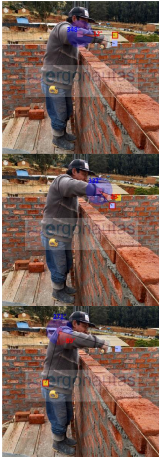
Figura N°31: Medición Grupo B: Colocación de bloques.
