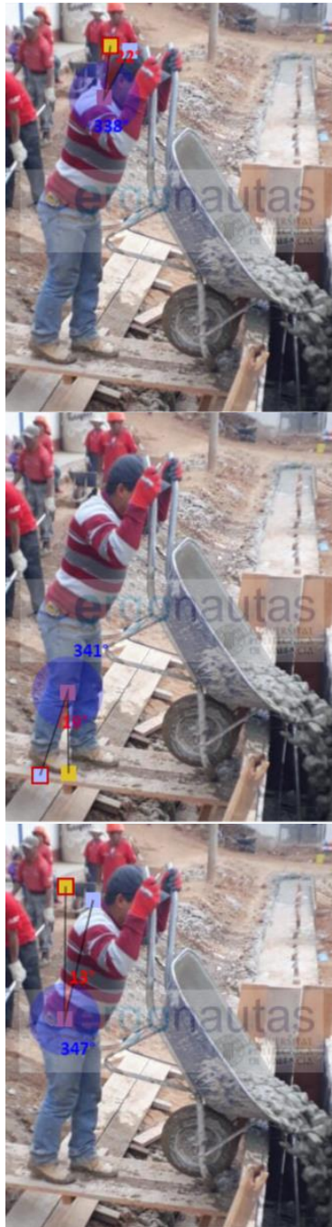
Figura N°89: Medición Grupo A: Vaciado de zapata 2.
