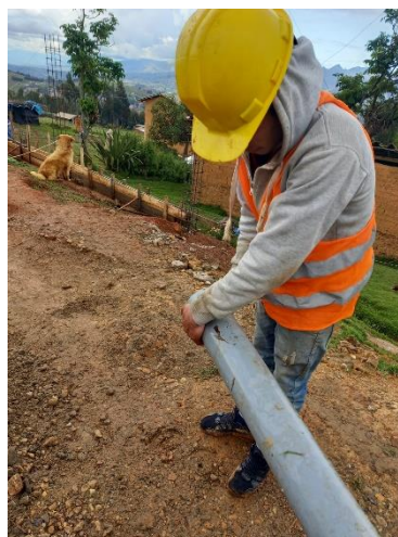
Figura N°70: Levantamiento de destino: Instalación sanitaria 1.
