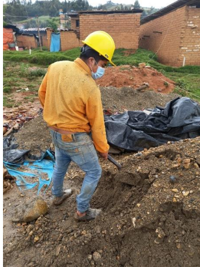
Figura N°116: Levantamiento de origen Post evaluación: Excavación 1
