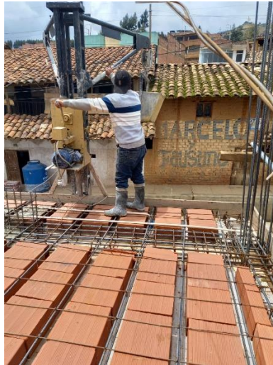
Figura N°132: Levantamiento de origen Post evaluación: Columnas-vigas-dinteles
