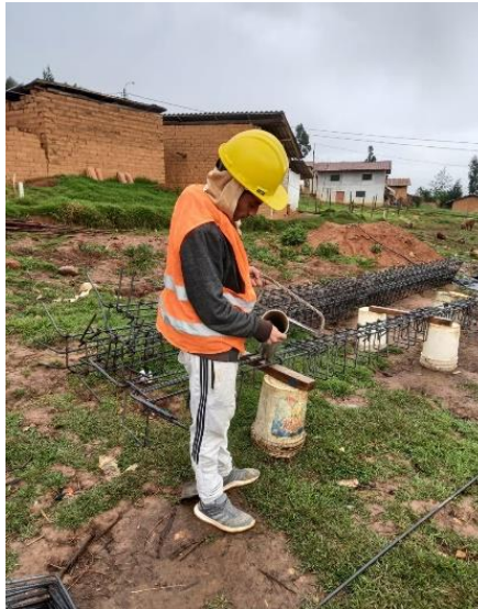
Figura N°112: Post evaluación de las extremidades superiores: Instalación sanitaria 1.
