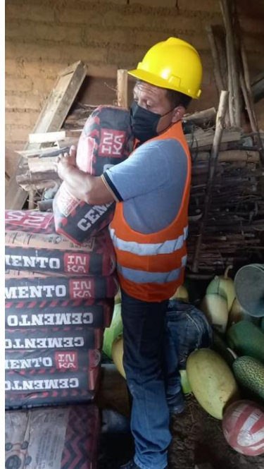
Figura N°124: Levantamiento de origen Post evaluación: Vaciado de zapata 2
