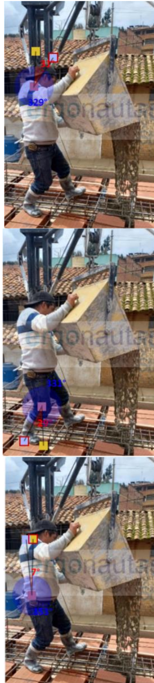
Figura N°100: Medición Grupo A: Columnas-vigas-dinteles.
