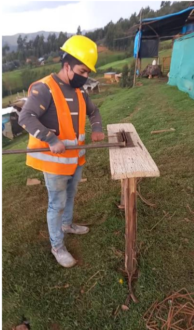
Figura N°121: Levantamiento de destino Post evaluación: Envarillado de zapata
