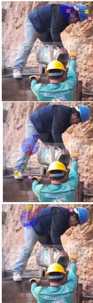
Figura N°39: Medición Grupo A: Columnas-vigas-dinteles.
