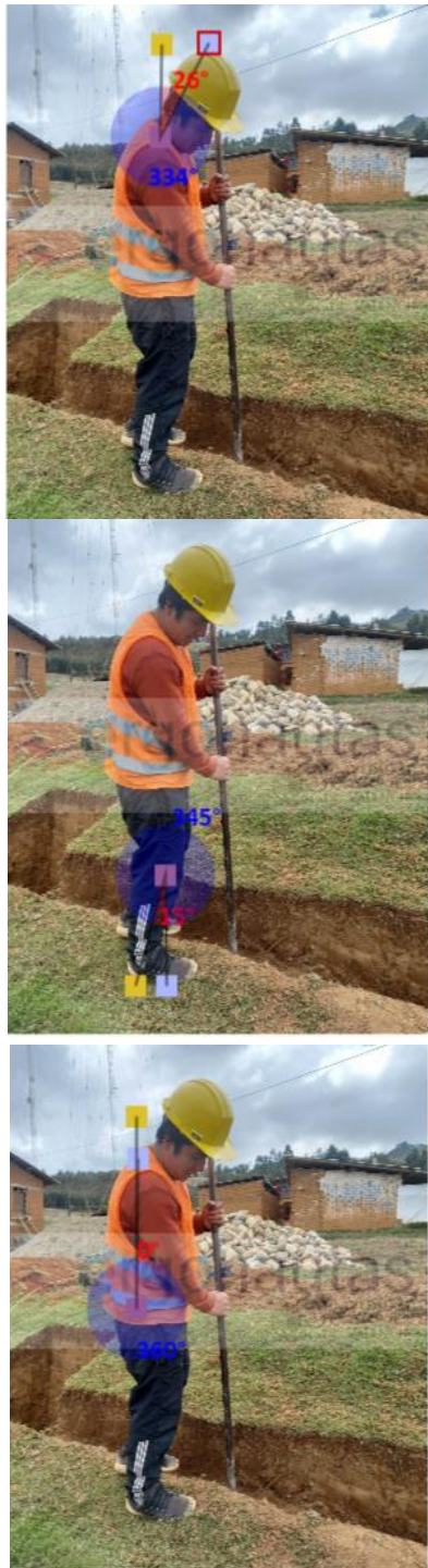
Figura N°77: Medición Grupo A: Excavación 1.
