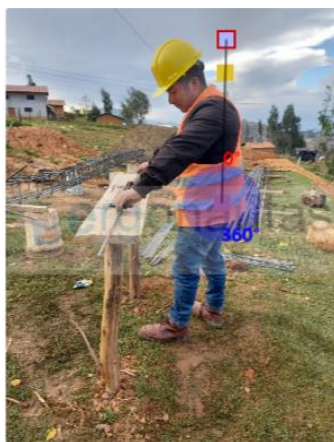
Figura N°83: Medición Grupo A: Envarillado de zapata.
