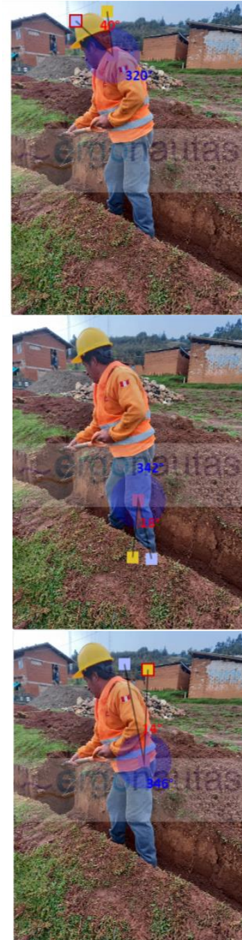
Figura N°80: Medición Grupo A: Excavación 2.
