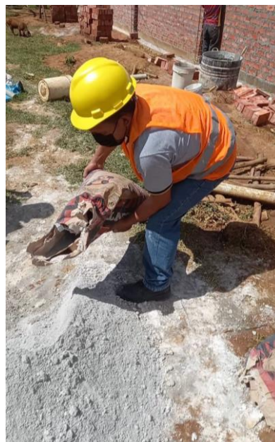
Figura N°66: Levantamiento de destino: Vaciado de zapata 2.
