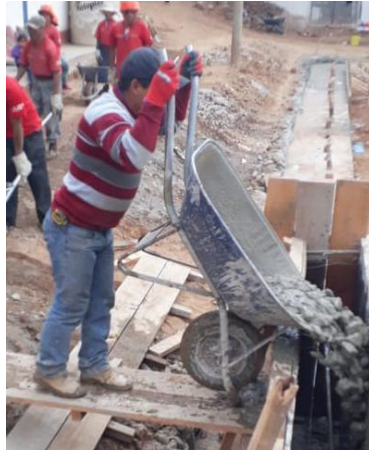
Figura N°110: Post evaluación de las extremidades superiores: Vaciado de zapata 2.
