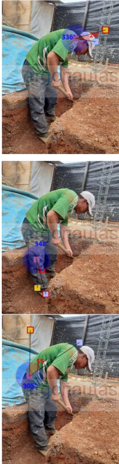
Figura N°15: Medición Grupo A: Excavación 1.
