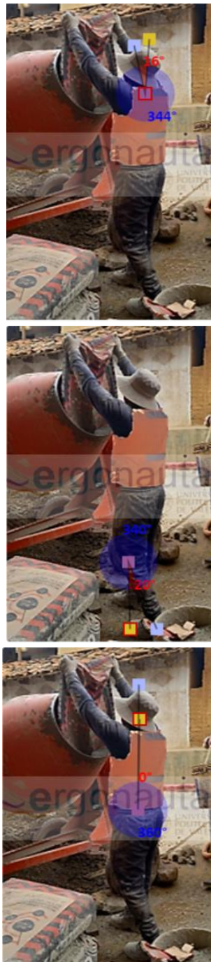
Figura N°86: Medición Grupo A: Vaciado de zapata 1
