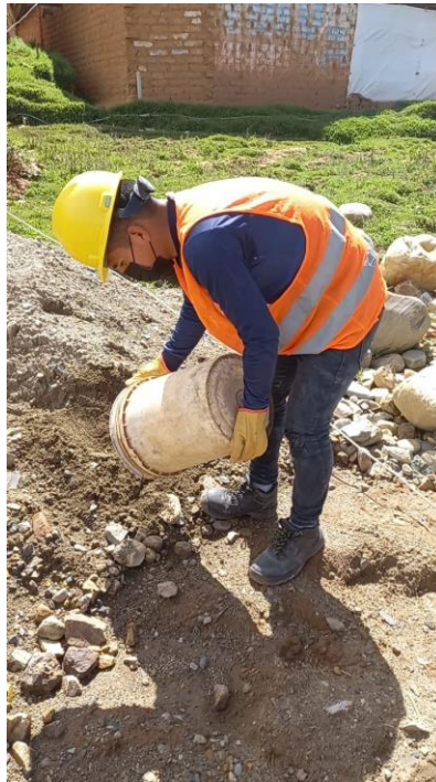
Figura N°64: Levantamiento de destino: Vaciado de zapata 1.
