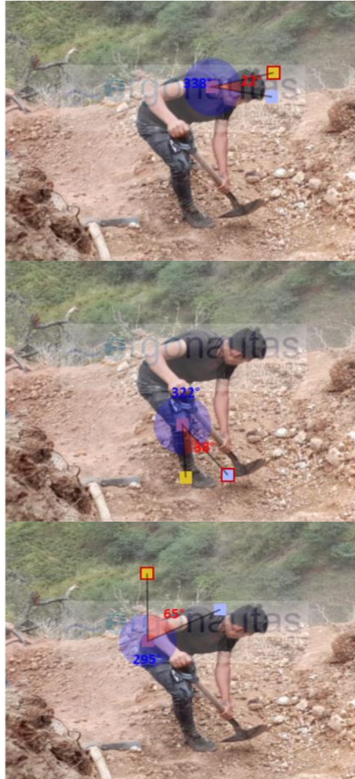
Figura N°18: Medición Grupo A: Excavación 2.
