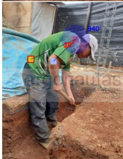
Figura N°16: Medición Grupo B: Excavación 1.
