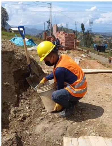
Figura N°63: Levantamiento de origen: Vaciado de zapata 1.
