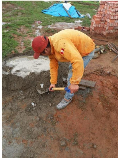
Figura N°57: Levantamiento de origen: Excavación 1.
