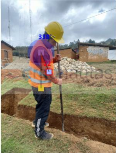
Figura N°78: Medición Grupo B: Excavación 1.
