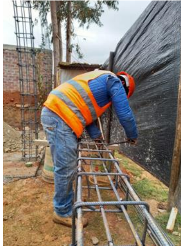
Figura N°47: Pre evaluación de las extremidades superiores: Envarillado de zapata.
