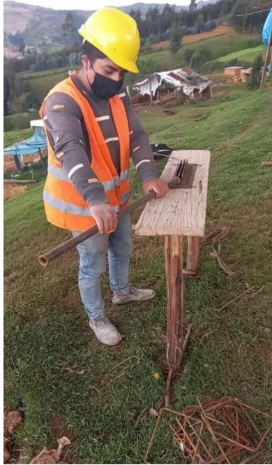
Figura N°120: Levantamiento de origen Post evaluación: Envarillado de zapata
