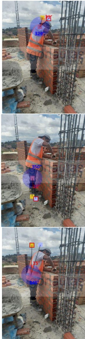
Figura N°92: Medición Grupo A: Colocación de bloques.
