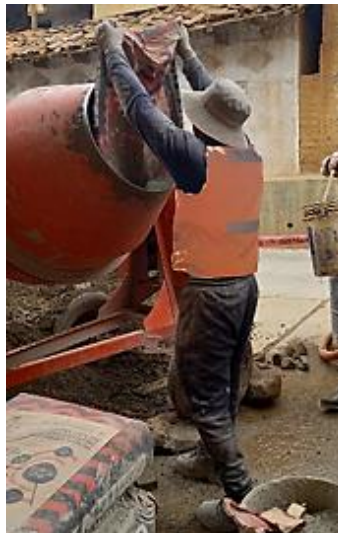
Figura N°109: Post evaluación de las extremidades superiores: Vaciado de zapata 1.
