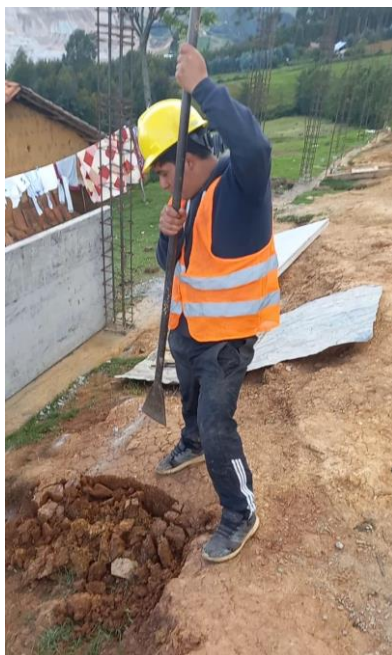
Figura N°119: Levantamiento de destino Post evaluación: Excavación 2
