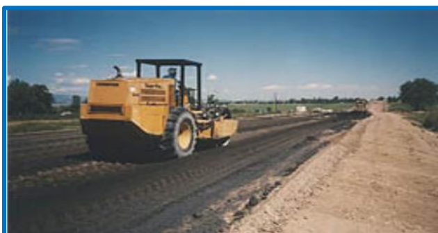
Figura 17. Mejoramiento de subrasante Fuente: Álvarez p. 124.
