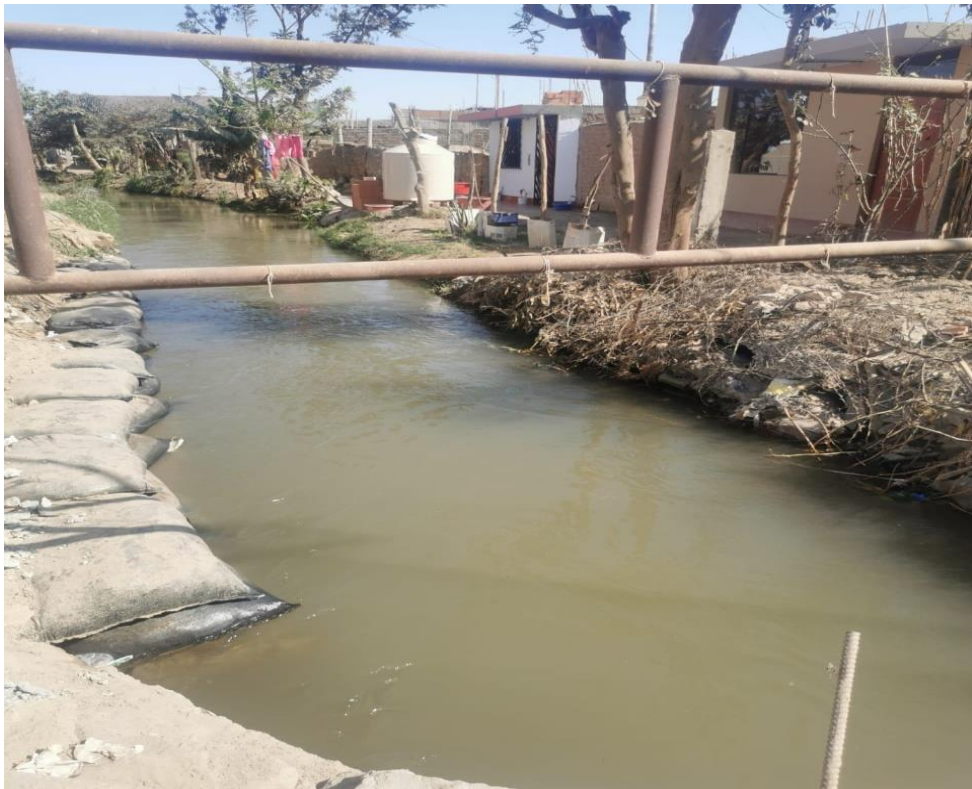
Fotografía 8. Zona de desborde
