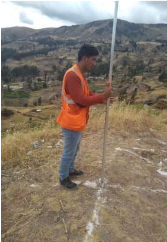
Nivelación en la poligonal de apoyo
