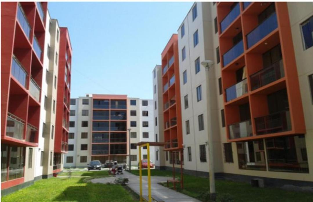
Figura 2: Edificaciones con Muros de Ductilidad Limitada en Chiclayo – Perú
