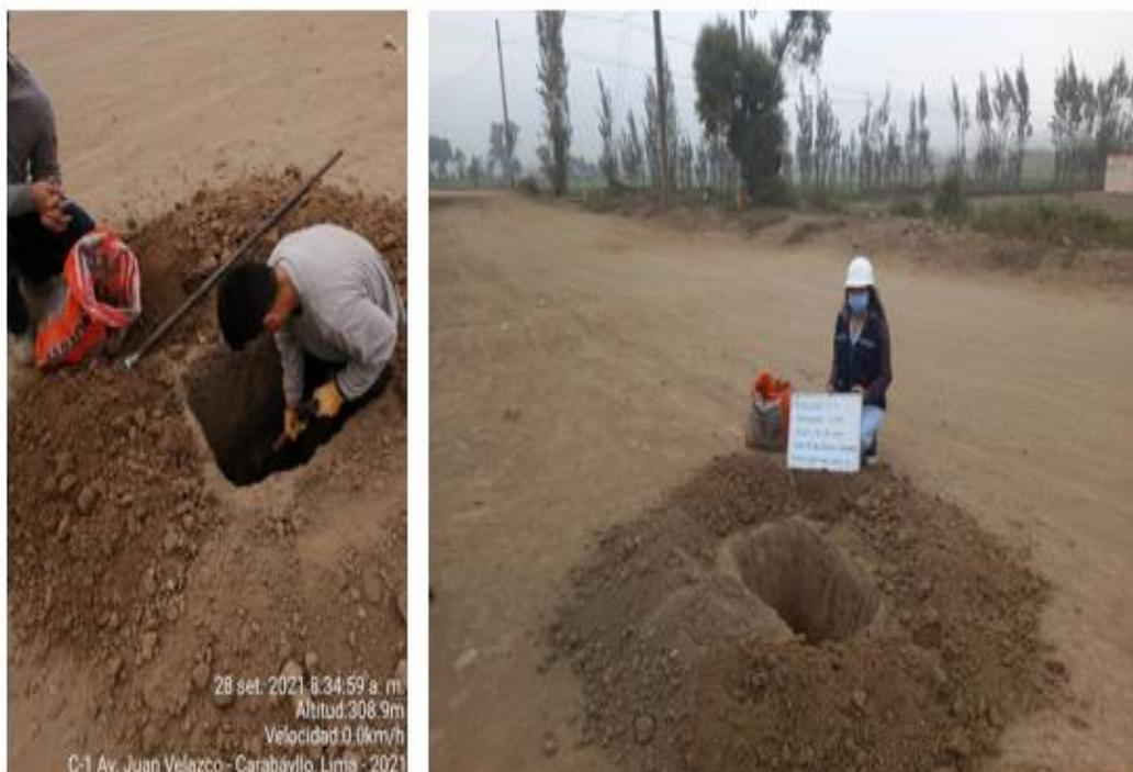
Imagen 5. Extracción de la muestra de C-1 de la Av. Juan Velazco
