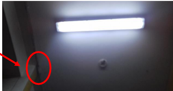
Figura 15: Techo del primer nivel Fuente: Elaboración Propia
