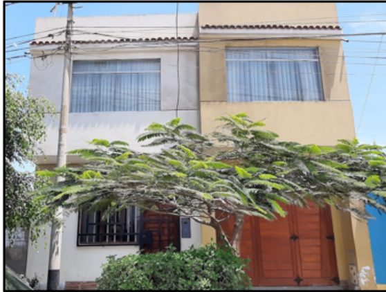
Imagen 1. Fachada de la vivienda.
