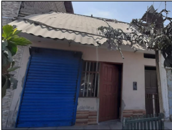
Imagen 1. Fachada de la vivienda.
