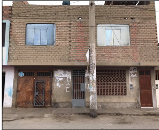
Imagen 1. Fachada de la vivienda.
