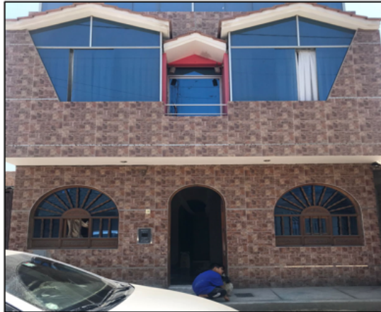
Imagen 1. Fachada de la vivienda.
