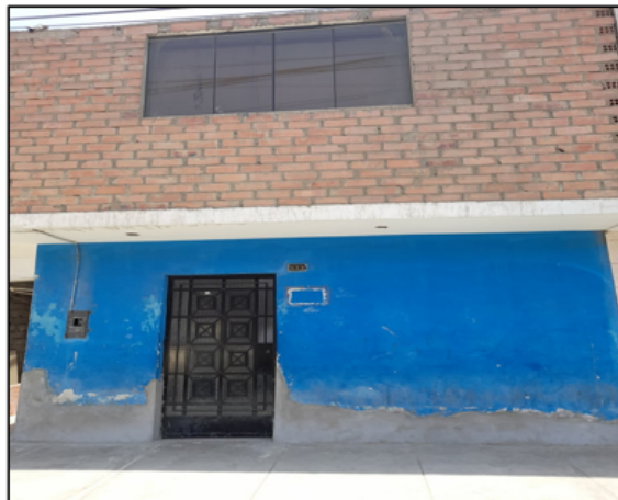
Imagen 1. Fachada de la vivienda.
