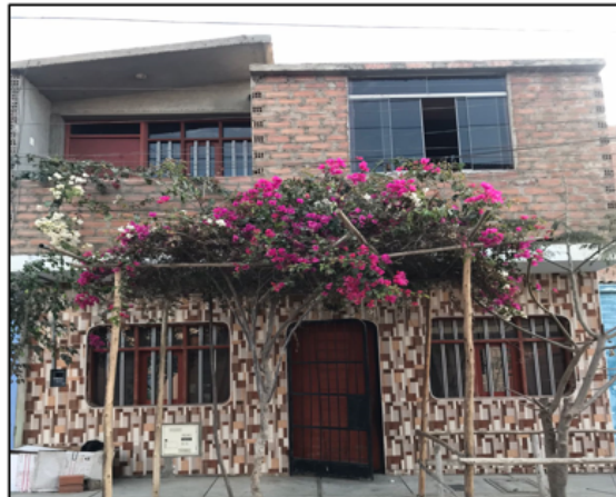
Imagen 1. Fachada de la vivienda.
