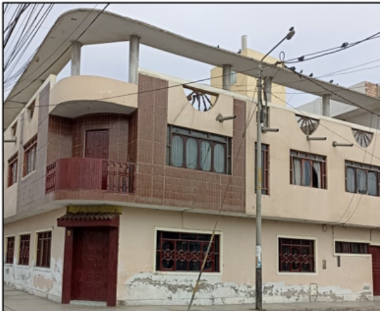
Imagen 1. Fachada de la vivienda.
