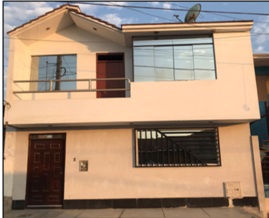
Imagen 1. Fachada de la vivienda.
