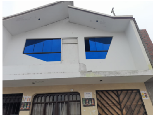
Imagen 1. Fachada de la vivienda.
