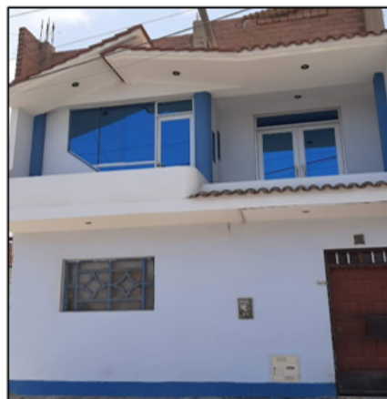
Imagen 1. Fachada de la vivienda.
