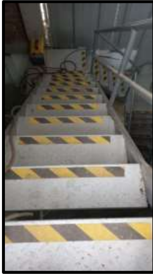
SEÑALIZACIÓN EN ESCALERAS
