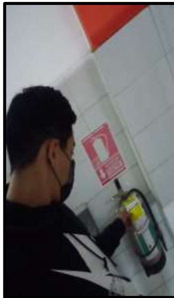
INSPECCIÓN DE EXTINTOR TIPO K
