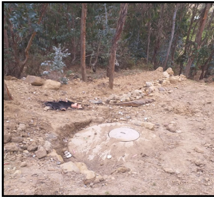
Figura 18. Servicio básico (Desagüe)
