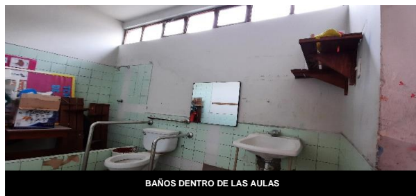
BAÑOS DENTRO DE LAS AULAS
