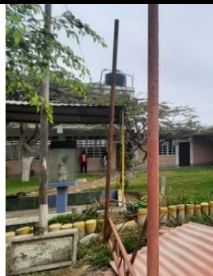
TANQUE DE AGUA
