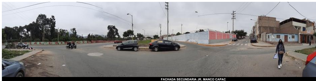
FACHADA SECUNDARIA JR. MANCO CAPAC
