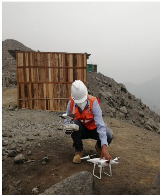
Figura 8. Ejecucion de vuelos fotogrametricos
