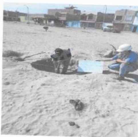
FOTOGRAFIA N°02: TECNICO MIDIENDO PROFUNDIDAD DE CALICATA N° 02
