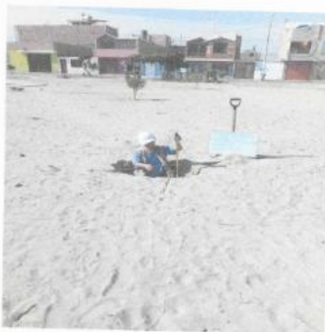
FOTOGRAFIA N° 01: TECNICO MIDIENDO PROFUNDIDAD DE CALICATA N° 01
