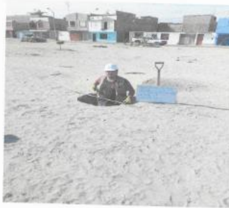
FOTOGRAFIA N° 03: TECNICO HACIENDO LA MEDICION DE LA CALICATA N° 03
