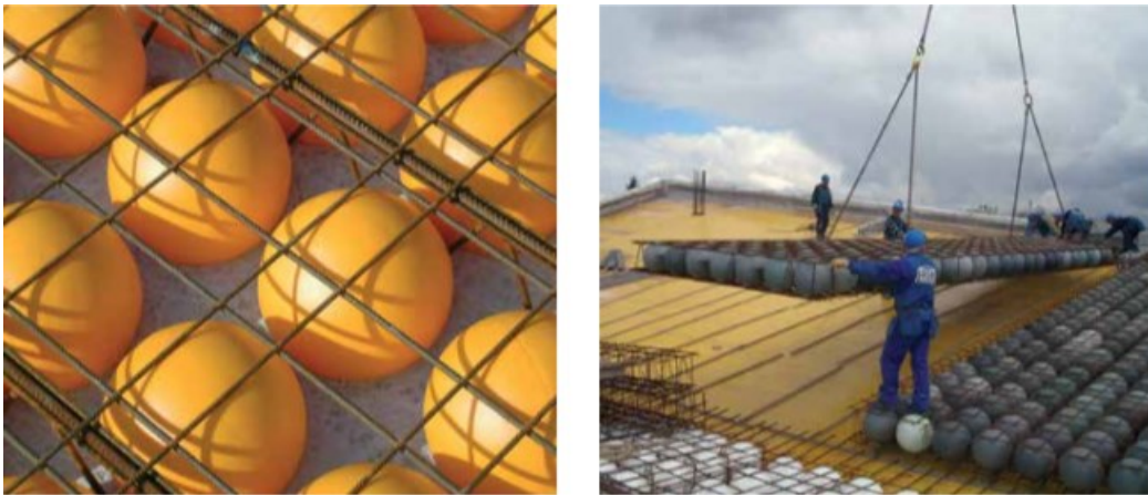
figura 11: Imagen de sistema BubbleDeck-Autor: Jorgen Bruenig
