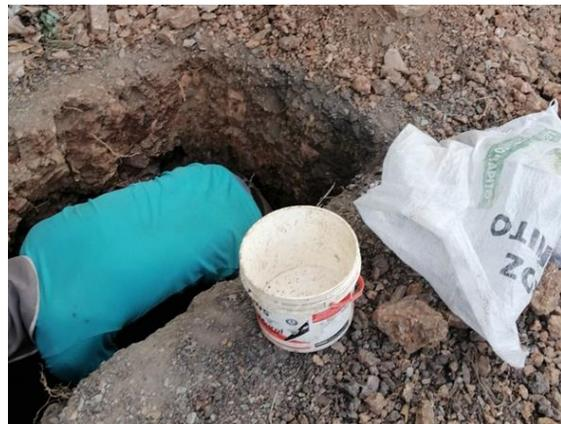
*Figura 10.* Extracción de material de la calicata N° 04.
